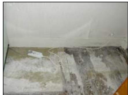
Images 157, 158 et 159. Un logement loi 1948 non réhabilité dans la Cour de Bretagne (juin 2004)
