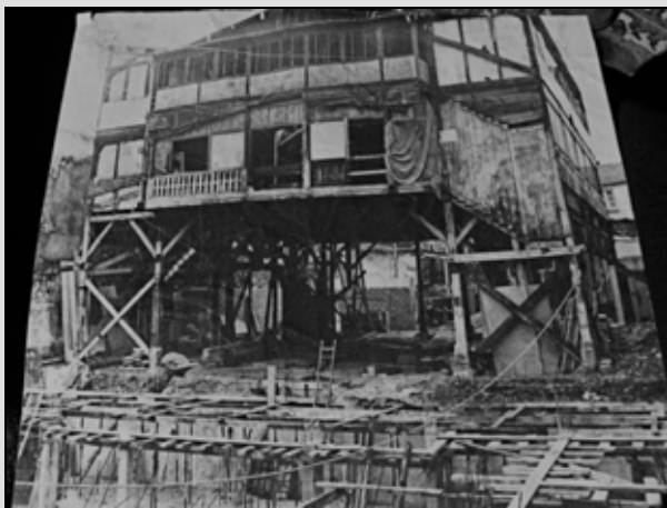
Image 64. Le Lavoir du Buisson Saint-Louis en travaux (photographie d'une habitante)
