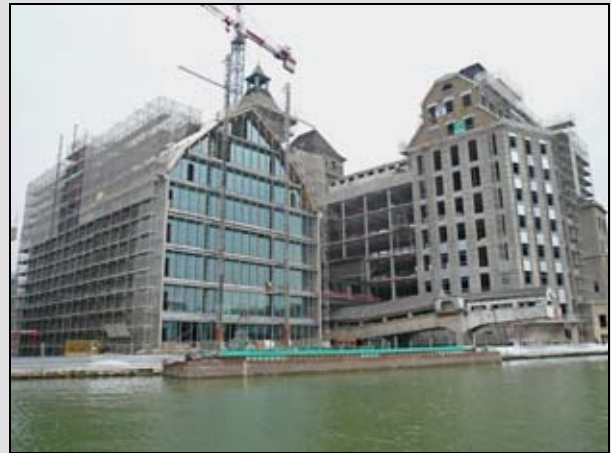
Image 12. Les anciens moulins de Pantin (Seine-Saint-Denis), sur les bords du canal de l'Ourcq, transformés en bureaux pour une filiale de BNP Paribas (juillet 2008)
