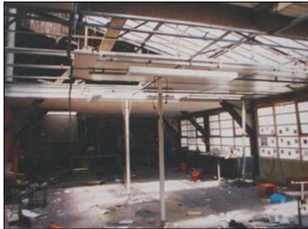
Image 55. Un local industriel à l'abandon dans le passage de la Fonderie au début des années 1990 (photographie d'une habitante)
