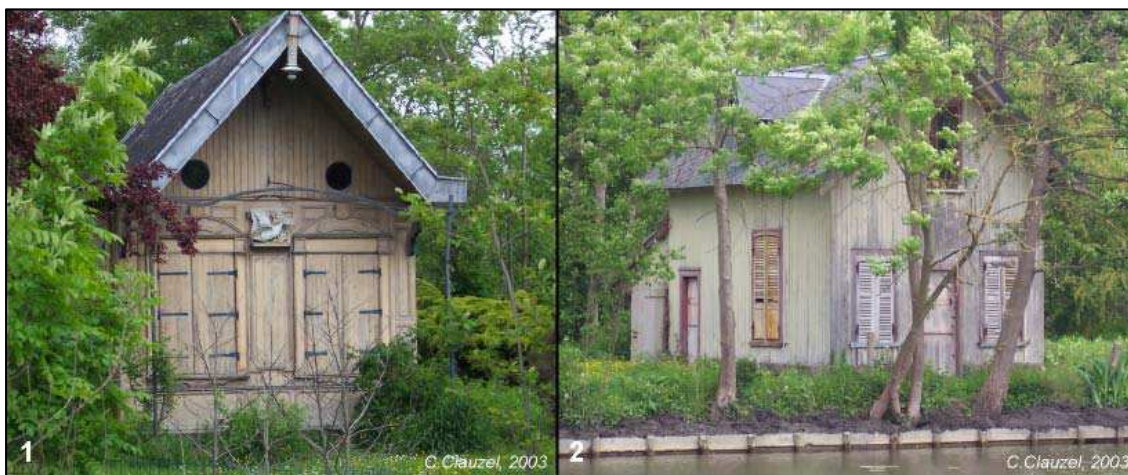
Planche 6 : Abris de jardin datant du XIX e siècle. Visibles depuis le chemin de halage, ces deux constructions en bois témoignent de la présence ancienne d'une urbanisation diffuse dans les hortillonnages. Si la cabane de gauche (n° 1) semble entretenue, celle de droite (n° 2) apparaît en mauvais état (volets rouillés et cassés, peinture défraîchie).
