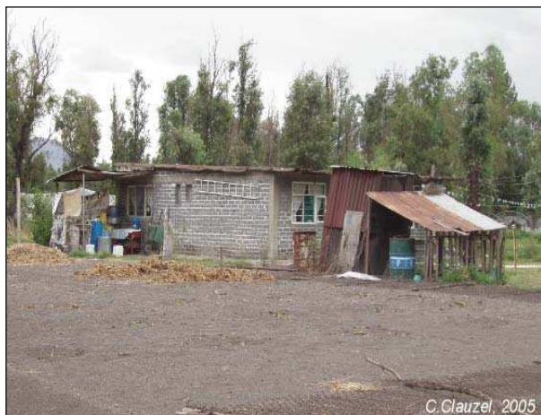
Photo 8 : Habitat précaire et irrégulier à San Gregorio Atlapulco. Si l'habitation est construite en parpaings de ciment, le toit et l'appentis ont été réalisés avec des matériaux de récupération. En arrière-plan, des saules en alignement sont visibles sur les berges d'un canal. L'espacement des arbres à gauche témoigne d'une probable exploitation ou d'une dégradation de leur état phytosanitaire.
