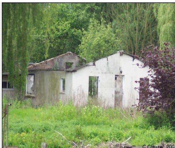
Photo 11 : Construction abandonnée dans les hortillonnages. Cette photographie représente une maison délabrée au milieu d'une végétation en phase de reconquête. En arrière-plan, la forte densité d'espèces ligneuses témoigne de la présence d'une parcelle boisée à proximité.
