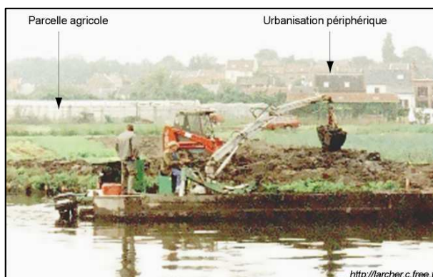
Photo 19 : Curage des canaux dans les hortillonnages à l'aide d'une pelle mécanique installée sur une barge.
