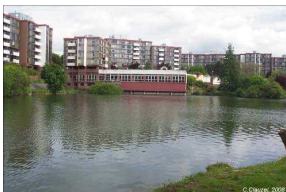
Photo 20 : Panorama sur les résidences de Beauvillé depuis les hortillonnages. Construites dans les années 1970, ces résidences sont constituées de deux ensembles distincts : des immeubles de six étages dédiés à l'habitation et une barre horizontale regroupant des bureaux.
