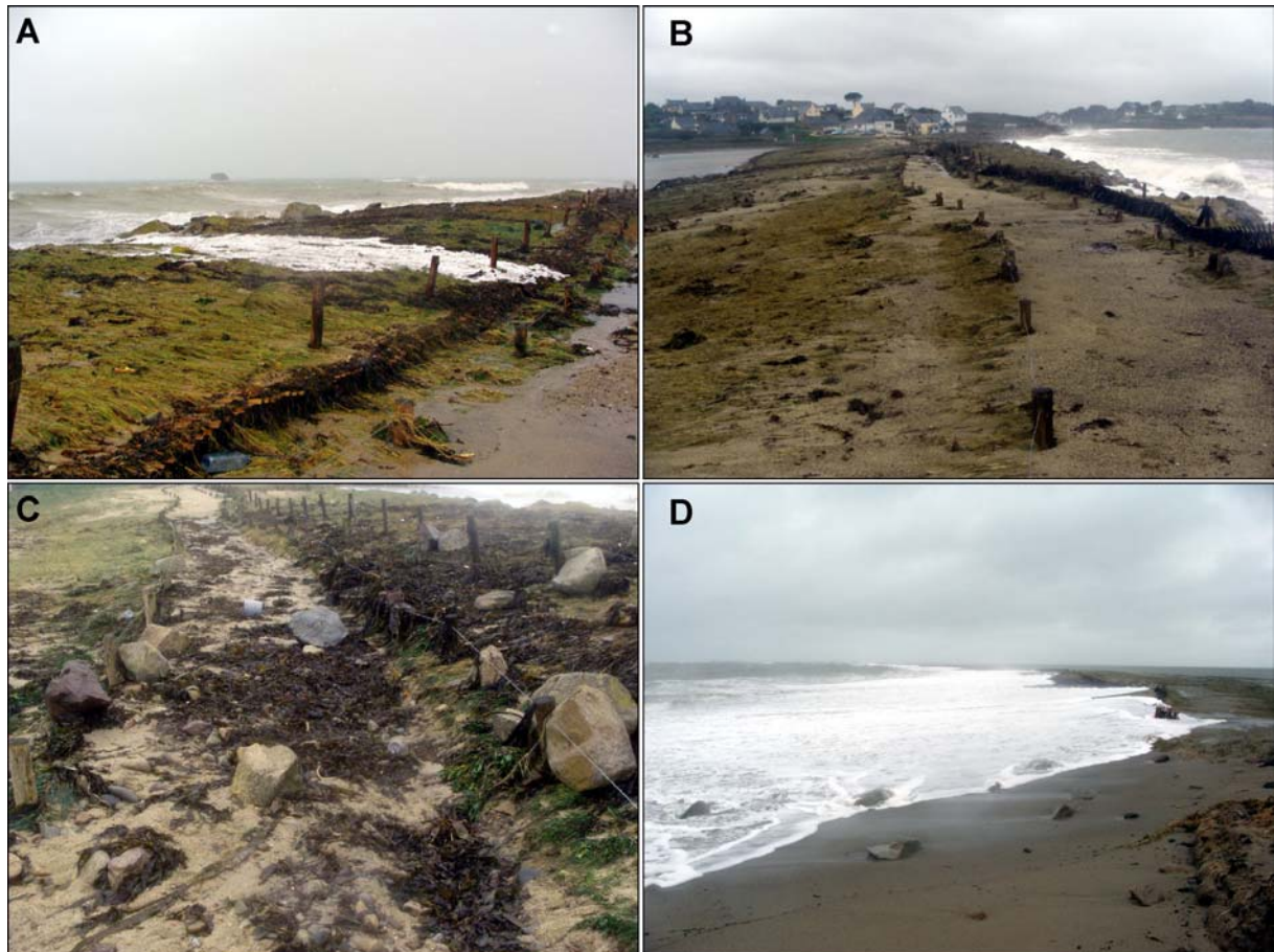
Photographie 32 : Impacts morphologiques de la tempête "Johanna" du 10 et 11 mars 2007. A. Nappe de submersion sur la racine dunaire du Sillon de Talbert. B. Dépôts d'overwash au sommet de la dune. C. Projections de galets et blocs par les vagues au sommet de la dune. D. Jet de rive précédant la submersion sur la partie proximale du Sillon. (Clichés : J. Houron, Conservatoire du Littoral, 11 mars 2007).
