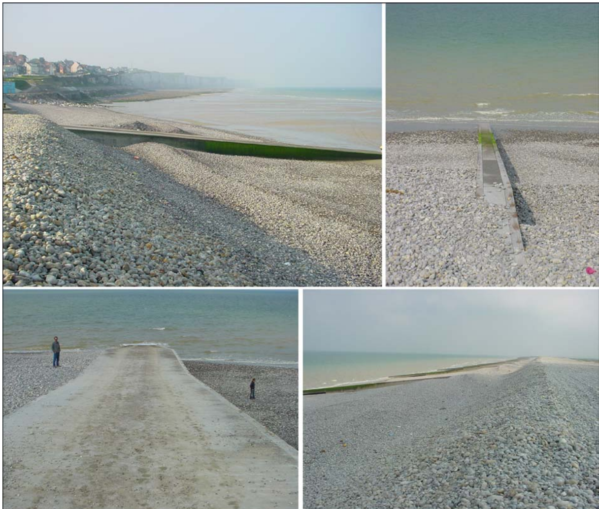
Photographie 39 :Epis installés dans la partie proximale de la flèche du Hourdel (clichés : S. Suanez, septembre 2007).
