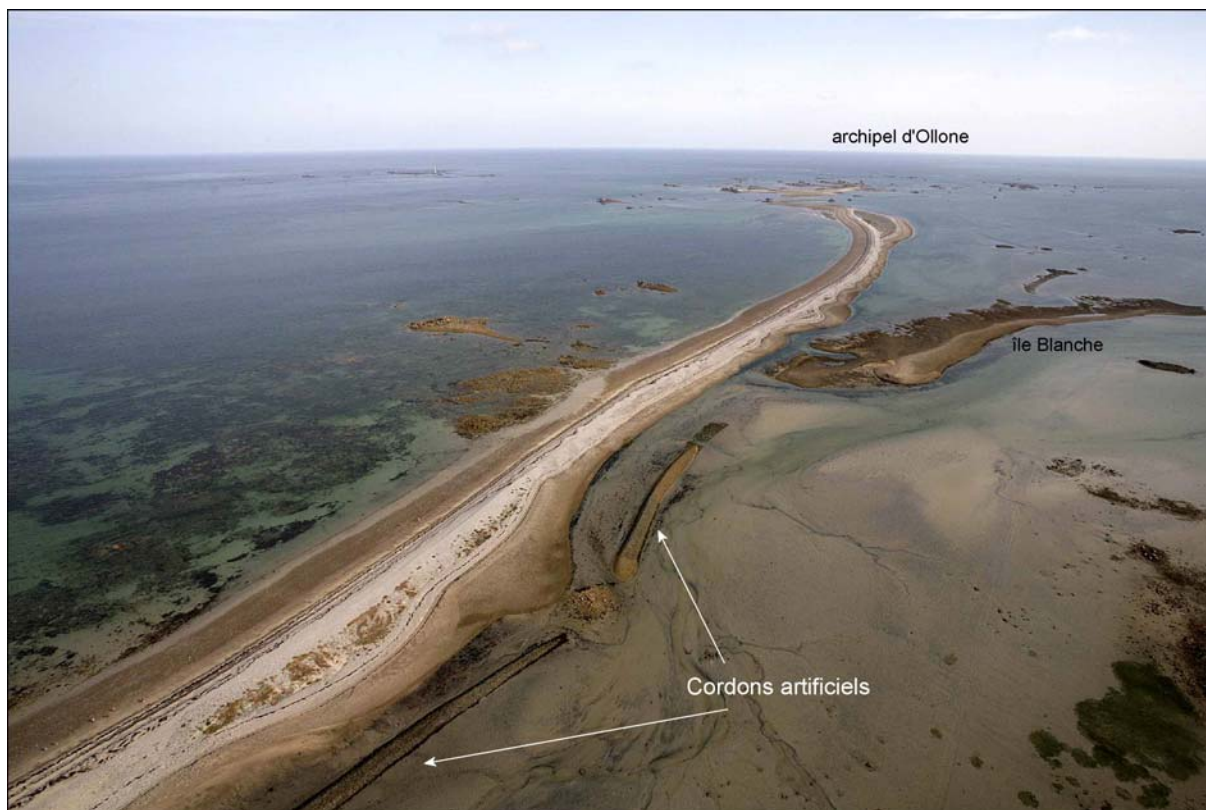
Figure 250 : Vue aérienne oblique du Sillon de Talbert et des enrochements artificiels mis en place sur le revers à l'automne 2004 (Cliché : D. Halleux, Conservatoire du Littoral, 2007).
