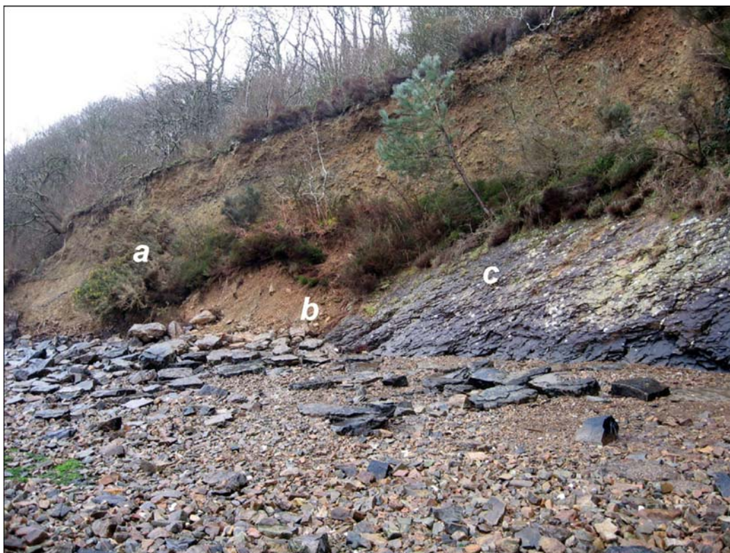
Photographie 29 : Dans le secteur d'alimentation de la flèche du Loc'h, falaise de head partiellement végétalisée (a), récemment rafraîchie à la base lors de la tempête Johanna des 10 et 11 mars 2008 (b). A proximité, affleure en pied de falaise la roche sous-jacente (quartzite) (c). A gauche du cliché, le haut d'estran est jonché de blocs décimétriques à métriques atténuant la compétence des vagues à la base des glissements. (Cliché : B. Fichaut, 21 mars 2008).
