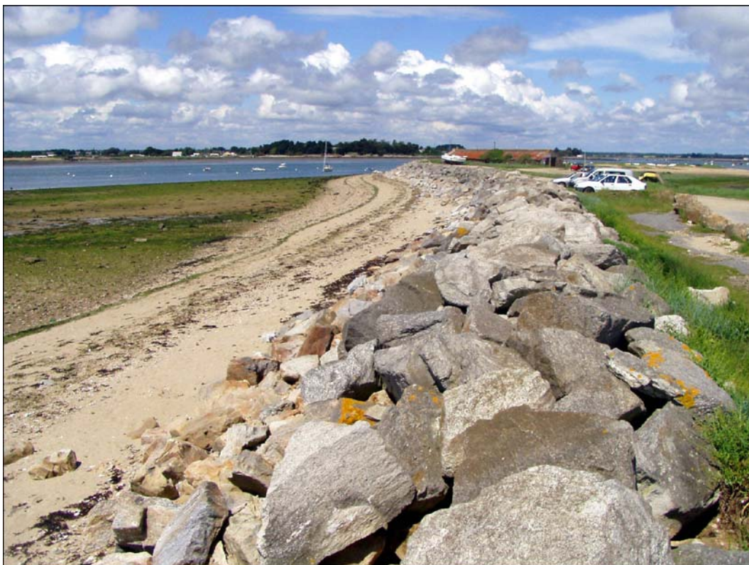
Photographie 27 : Enrochement sommital sur la flèche de Dibenn.
