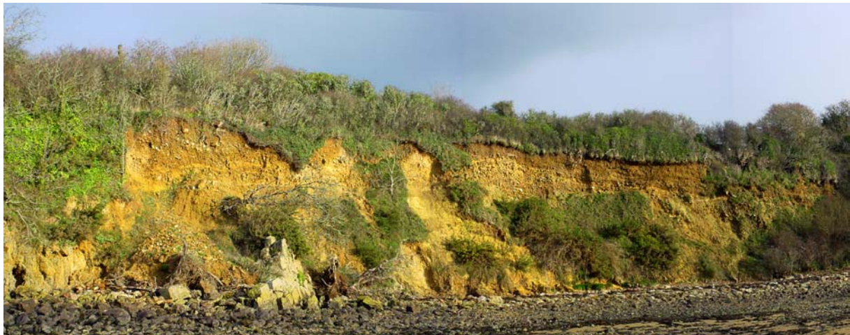
Photographie 6 : Glissements et éboulements des falaises de l'anse du Caro en rade de Brest (cliché : S. Suanez).
