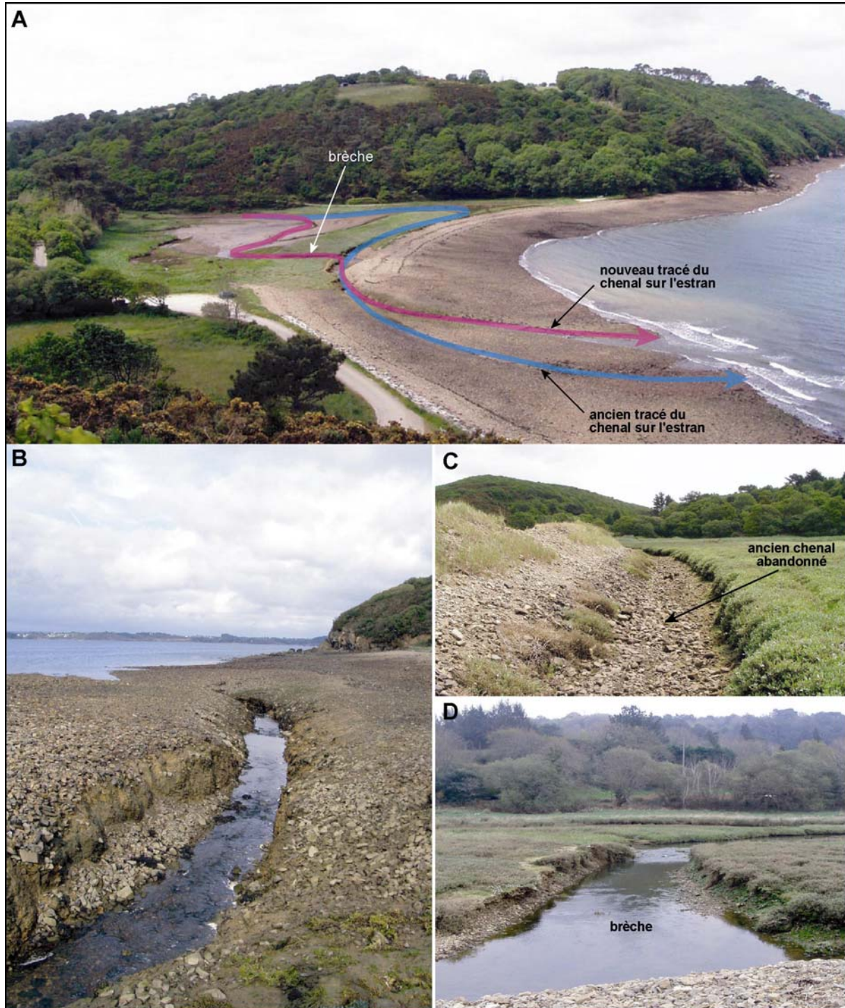
Figure 205 : A. L'ouverture d'une brèche dans la flèche interne du Loc'h en décembre 2003 a entraîné une défluviation du chenal de marée sur l'estran qui adopte un tracé plus direct vers la mer et au sein duquel les courants de marée sont renforcés. B. Le nouveau chenal de marée se présente sous la forme d'une gorge d'une profondeur pouvant atteindre 2 m par endroits. C. Ancien chenal de marée situé entre la flèche interne et la flèche externe désormais abandonné au profit de la brèche. D. Brèche formée dans le cordon interne du Loc'h. (Clichés : P. Stéphan, mai 2006).
