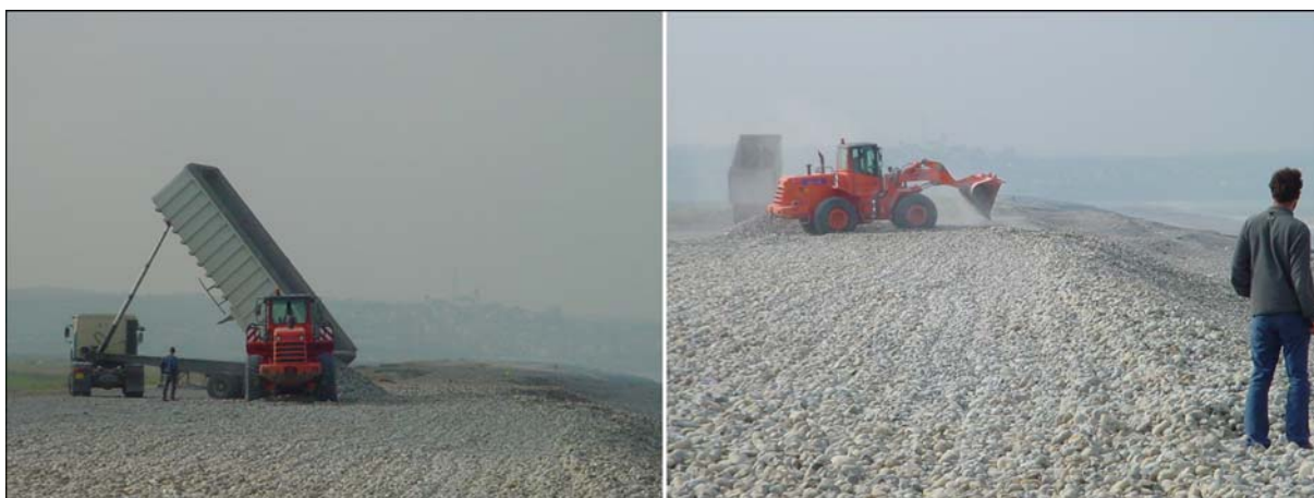
Photographie 40 : Rechargements en galets du haut de plage dans la partie proximale de la flèche du Hourdel (clichés : S. Suanez, septembre 2007).
