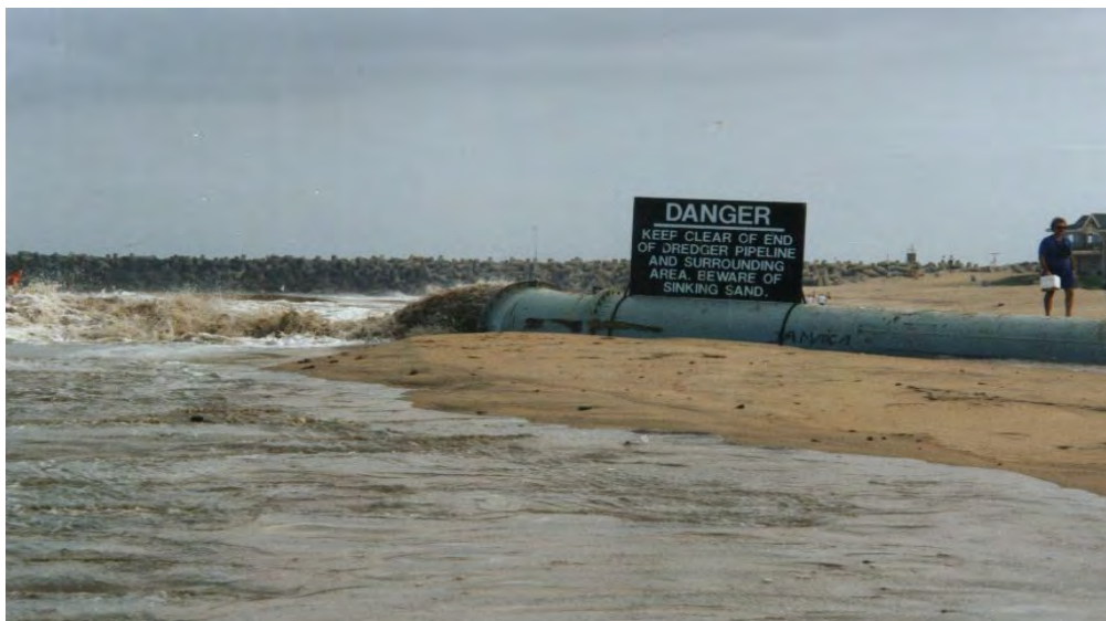
Photo 77 : L'exutoire de la conduite de dragage sur la plage publique à Richards Bay
