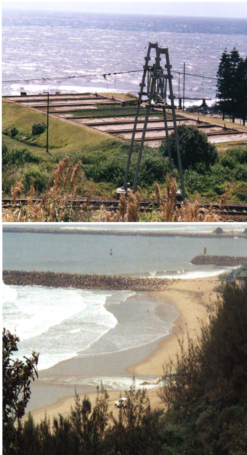
Photo 63 : Port Shepstone, les bassins de rétention des eaux usées sur le front de mer Photo 64 : Richards Bay : l'exutoire de la conduite de dragage sur la plage publique
