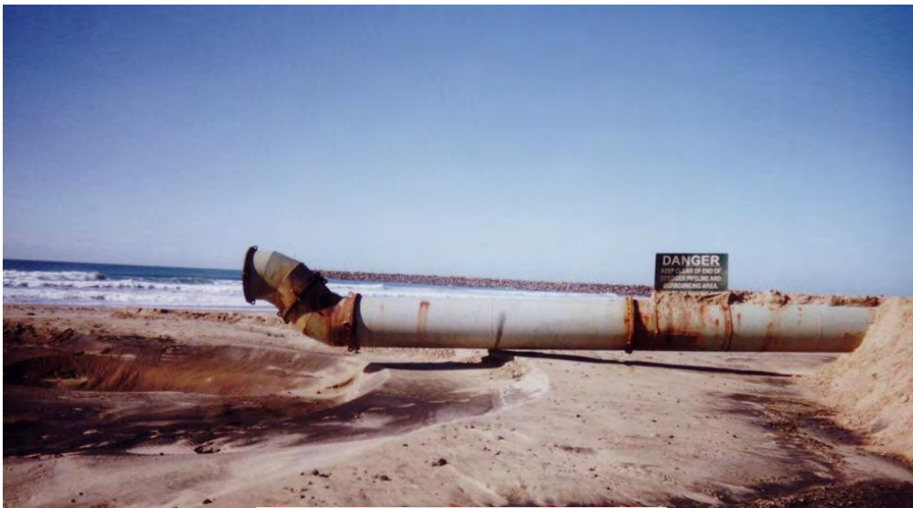
Photo 80 : La conduite à marée basse
