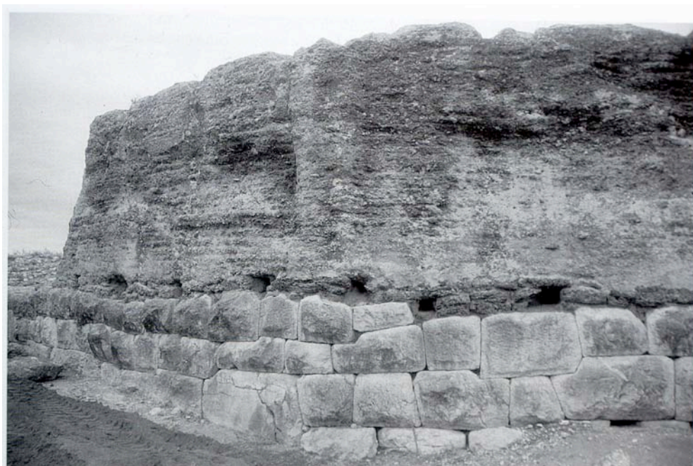
Fig. 16. Mur en opus caementicium sur socle polygonal de l'enceinte romaine d' Emporiae (angle sud-ouest), d'après AQUILUÉ.
