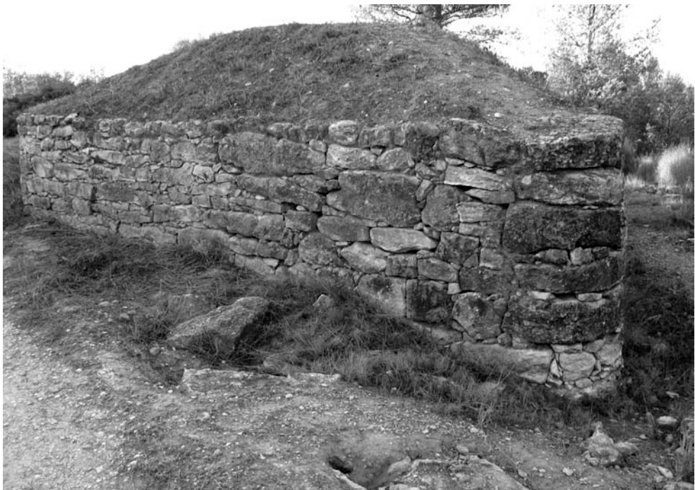
Fig. 2. En haut : les deux tours vues de l'est ; en bas : bec de la tour Nord, vu du sud-est.
