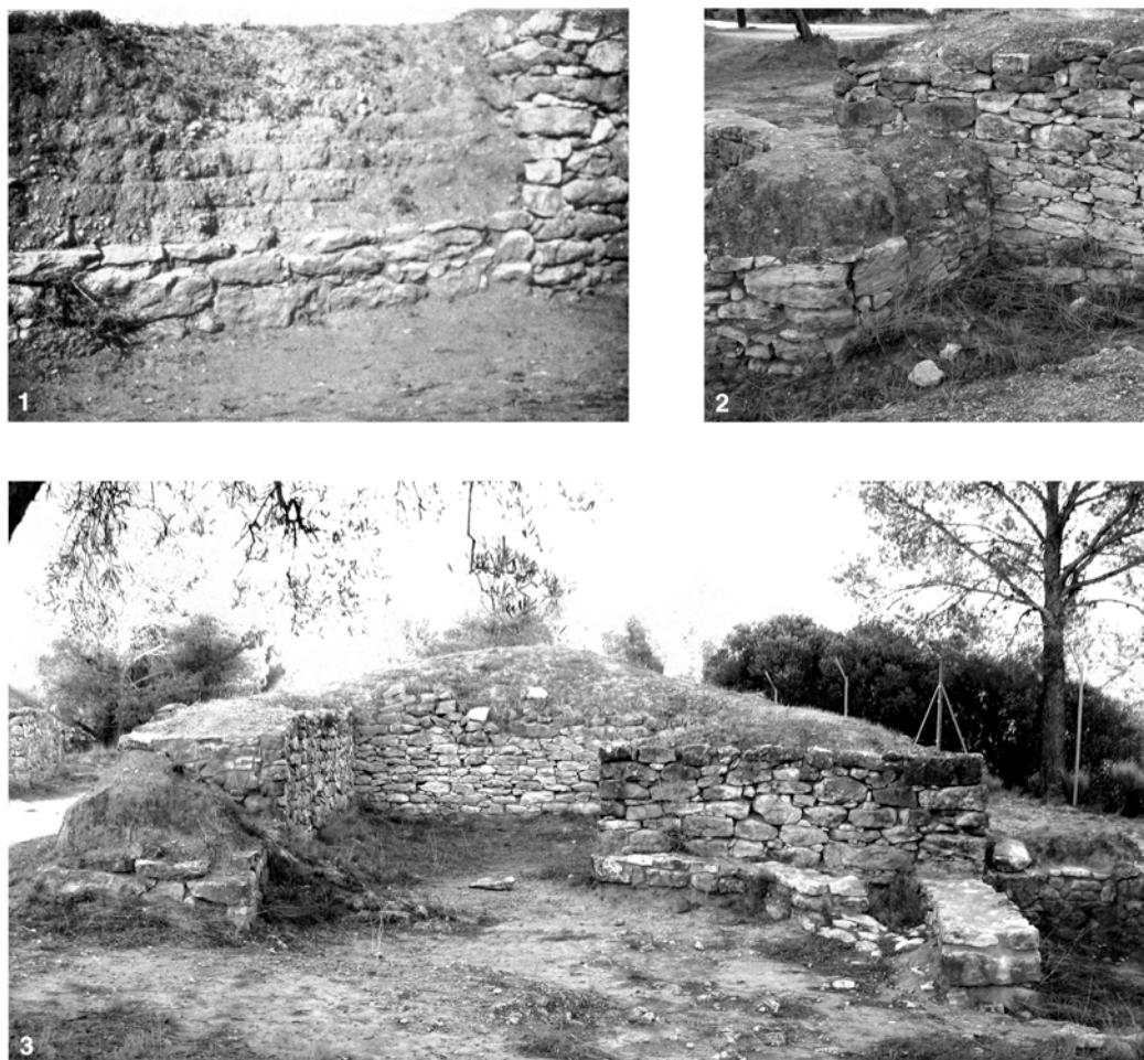
Fig. 8. Détails de la tour Sud. 1 : Assises d'adobes en place sur le mur E (d'après VILASECA et al. 1949) ; 2 : muret I entre la maison adjacente et le mur B de la tour ; 3 : les constructions à l'arrière de la tour, vues de l'ouest.
