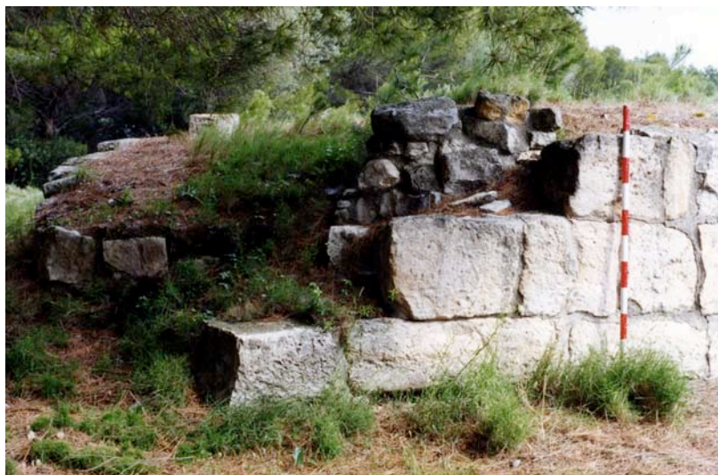
Fig. 2. Détail de l'appareil du dernier état de la porte de Pech Maho. On devine à l'arrière du parement récent l'appareil de petits blocs irrégulier de la phase antérieure.
