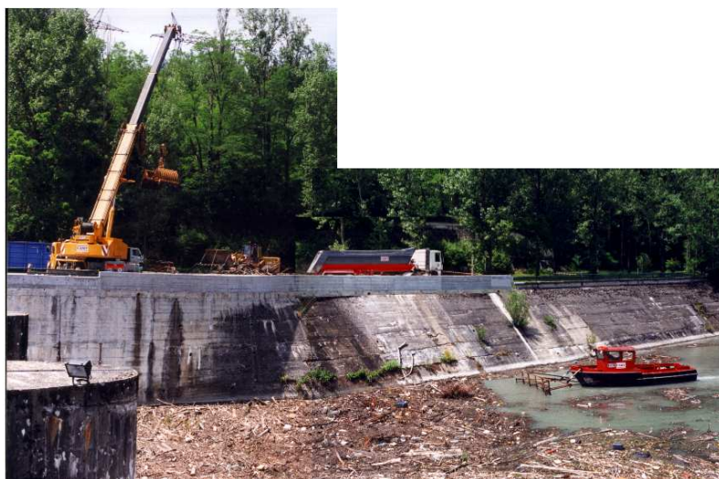
Photographie 5 – L'extraction des bois flottants au barrage de Génissiat (cliché : Moulin B., 1999).
