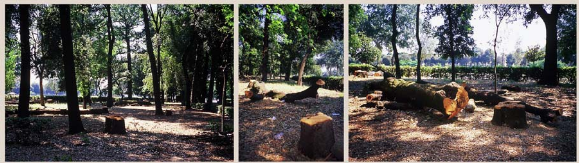
Illustration 31 : Travaux d'abattage au cœur du parc delle cascine Pardo, C., juin 2003, Firenze
