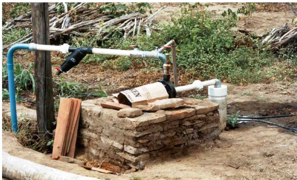
Figura An 1: Poço tubular de 8,2 m de profundidade e vazão de 23 \text{ m}^3 \cdot \text{h}^{-1} , usado para irrigação de uma área de 2 ha e para o abastecimento doméstico da família do agricultor
