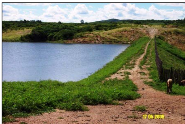
Figura II-9: Reservatório de L.Cercada.
