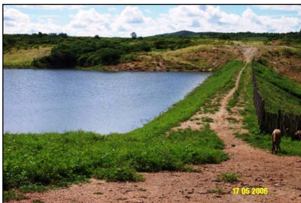
Figura II-9: Reservatório de L.Cercada.
