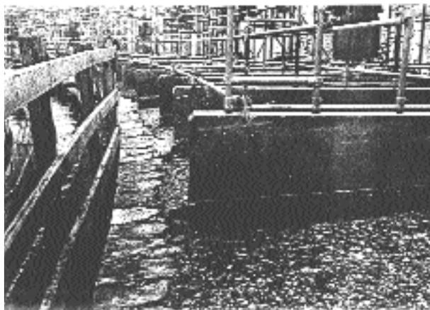
Fig. 493. À l'amphithéâtre de Nîmes, « murettes de béton et échafaudages tubulaires édifîés malgré les interdictions en 1956 et destinés à supporter des gradins en bois ». Phot. L.-Ph. May (?), 27 janvier 1957. (Arch. C.M.H., 885/3.)
