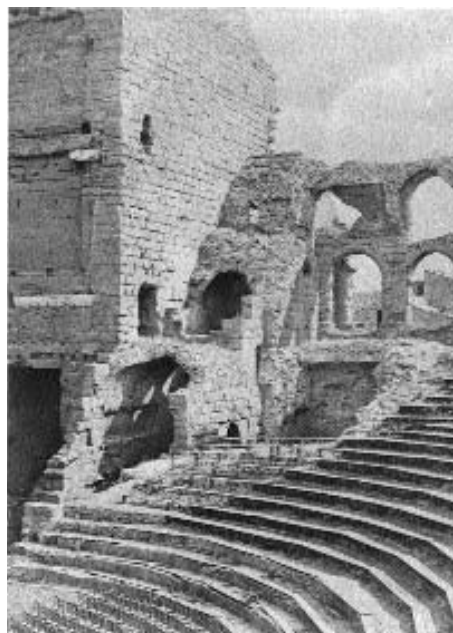
Fig. 280. L'installation des « banquettes volantes » sur l'ima cavea du théâtre d'Orange, côté est, 1869. (Phot. Brion, fonds privé Abel, Orange.)
