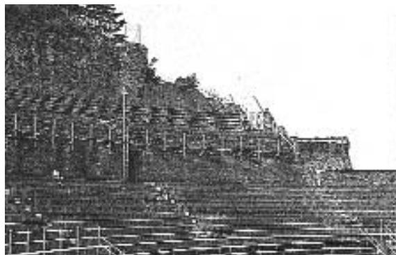
Fig. 506. Les garde-corps scellés sur les murs de *præcinctio* et à chacune des extrémités du 3<sup>me</sup> *mænianum* du théâtre d'Orange. (Phot. V. Chevrier.)
