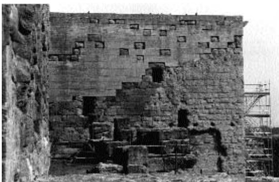
Fig. 327. Les reprises en pierres de taille posées à joint vif en 1875 sous la direction de P. Daumet, et parfaitement visibles encore aujourd'hui sur toute la partie supérieure du mur latéral à droite de la scène du théâtre d'Orange. (Phot. V. Chevrier.)
