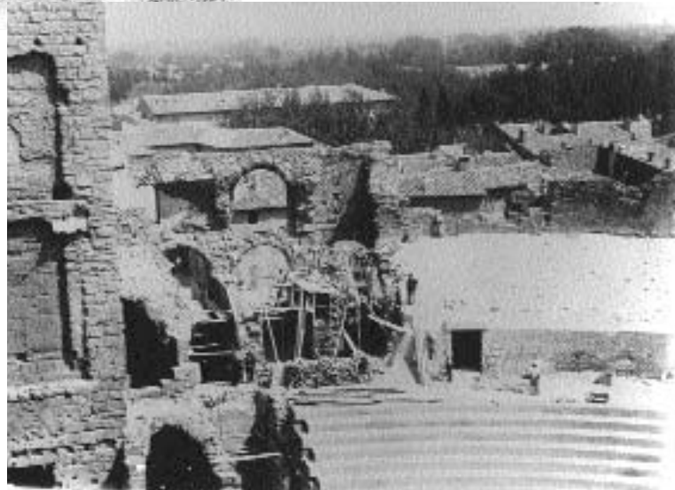
Fig. 286. La fermeture de la brèche est au-dessus du grand vomitoire latéral, après 1905. (Fonds privé Abel photo, Orange.)
