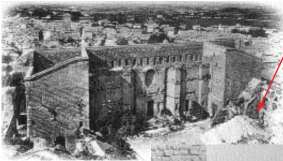
Fig. 285. Le théâtre d'Orange vu à vol d'oiseau montrant l'excavation à l'arrière de l'ima cavea, côté est, 1901. (Carte postale, ND phot., fonds personnel.)
