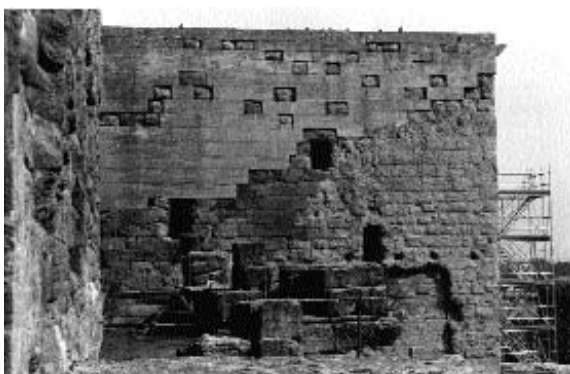
Fig. 327. Les reprises en pierres de taille posées à joint vif en 1875 sous la direction de P. Daumet, et parfaitement visibles encore aujourd'hui sur toute la partie supérieure du mur latéral à droite de la scène du théâtre d'Orange. (Phot. V. Chevrier.)
