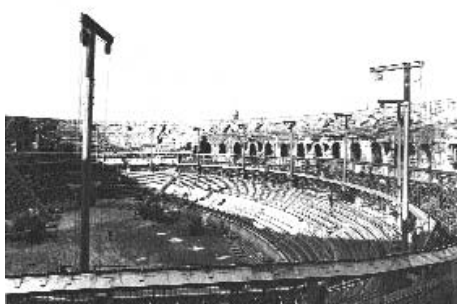
Fig. 456. Les grues manœuvrant sur la piste de l'amphithéâtre de Nîmes lors du chantier de montage de la « bulle », décembre 1988. (Nîmes. Le monument du spectacle, plaquette, 1988.)
