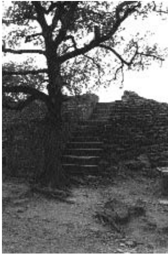
Fig. 325. L'escalier de l'un des vomitoires du théâtre de Vaison, côté ouest, restauré par J. Formigé. (Phot. V. Chevrier.)
