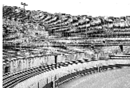
Fig. 485. Les échafaudages en tubulure régnant au-dessus des deux premiers mœniana de l'amphithéâtre d'Arles. (Phot. V. Chevrier.)
