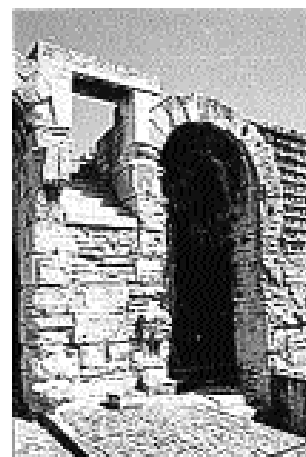
Fig. 346. L'escalier inscrit en 1905 par J.-C. Formigé de manière systématique une travée sur deux entre les arceaux du premier étage de l'amphithéâtre d'Arles. (Phot. V. Chevrier.)
