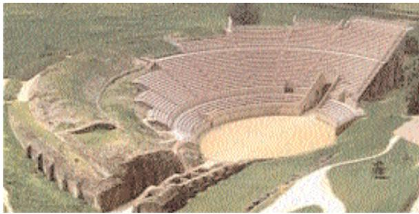
*Fig. 540 b. L'amphithéâtre de Grand et la reconstitution de sa cavea en ossature métallique. (Phot. Cl. Philip, <http://www.exagonline.com>.)*
