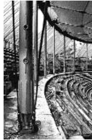
Fig. 459. Les poteaux de soutien de la « bulle » prenant appui sur la deuxième præcinctio. (Phot. V. Chevrier.)
