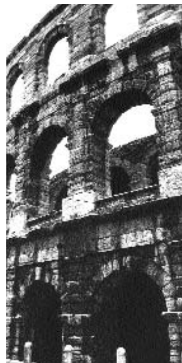
Fig. 54. Les trois arcades superposées de la façade des arènes de Vérone, encore en place côté nord. (Phot. J.-C. Golvin.)
