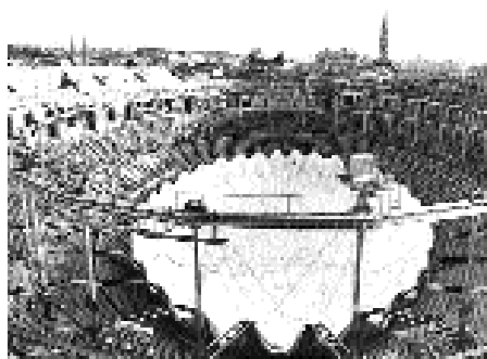
Fig. 457. Le montage de la lentille de toile destinée à couvrir les Arènes de Nîmes, décembre 1988. (Nîmes. Le monument du spectacle, plaquette, 1988.)
