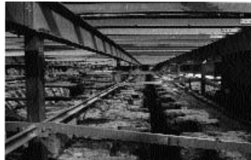
Fig. 423. Le plateau scénique du théâtre d'Orange recouvrant l' hyposcænum et la fosse du rideau. (Phot. V. Chevrier.)
