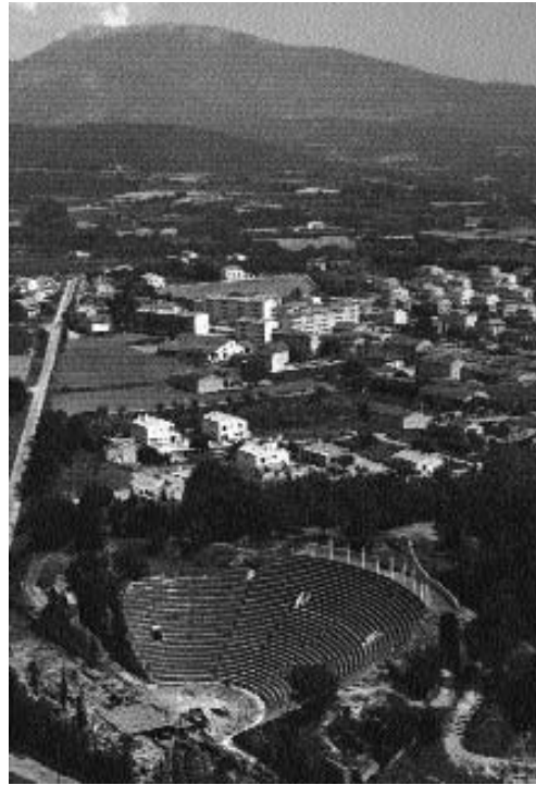
Fig. 322. Le théâtre après les travaux de J. Formigé, et tel qu'il apparaît aujourd'hui. (Carte postale, éd. Cellard.)
