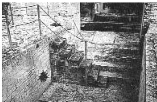
Fig. 504. Six marches de facture moderne combinées à celles du grand escalier d'entresol de l'amphithéâtre d'Arles. (Phot. V. Chevrier.)
