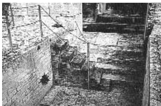
Fig. 504. Six marches de facture moderne combinées à celles du grand escalier d'entresol de l'amphithéâtre d'Arles. (Phot. V. Chevrier.)
