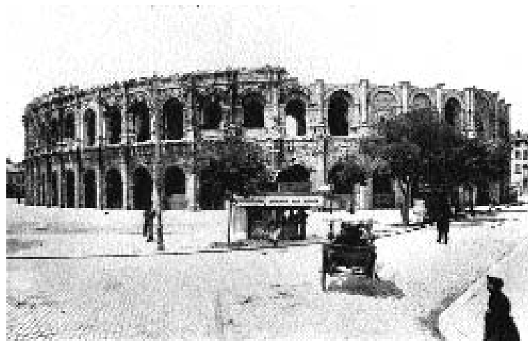
Fig. 242. Le dégagement de la façade est de l'amphithéâtre de Nîmes par la création d'une place elliptique telle qu'elle se présentait encore au début du XX e s. (Phot. anonyme, fonds M. Pradel, Nîmes).
