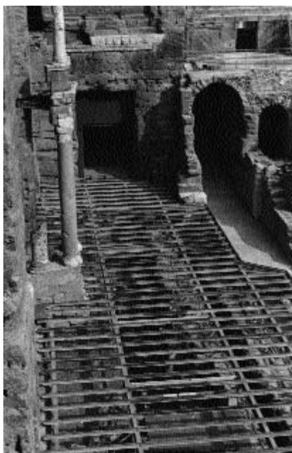
Fig. 424. Les poutrelles de fer du plateau de scène du théâtre d'Orange éloignées de quelques centimètres du mur de la *scænæ frons*. (Phot. V. Chevrier.)
