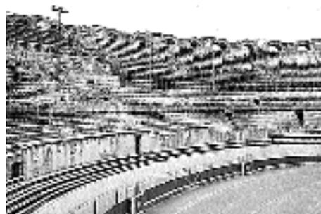
**Fig. 485.** Les échafaudages en tubulure régnant au-dessus des deux premiers maeniana de l'amphithéâtre d'Arles. (Phot. V. Chevrier.)
