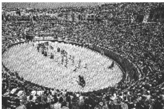
Fig. 507. L'aspect de ruine de l'amphithéâtre de Nîmes donnée par la partie médiane dépourvue de gradins. (Carte postale, phot. Pervanchon.)
