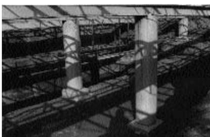
Fig. 426. Quelques-uns des socles de béton pris dans les vestiges du théâtre de Vaison et soutenant l'armature de fer du plateau de scène. (Phot. V. Chevrier.)
