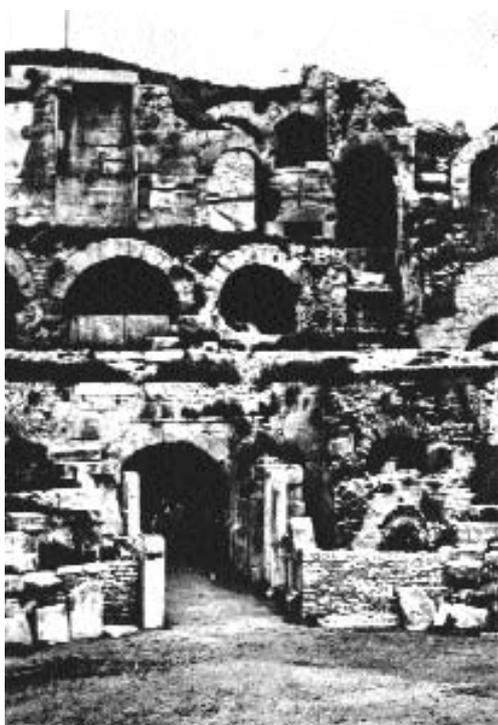
Fig. 304. Vue intérieure de l'amphithéâtre de Nîmes, et les « brèches du podium » de part et d'autre de la grande entrée orientale, vers 1850. Le mur d'enceinte du podium a été remonté en avant de ces brèches sans doute au tout début du XIX<sup>e</sup> siècle. (Phot. fonds privé M. Pradel, Nîmes.)
