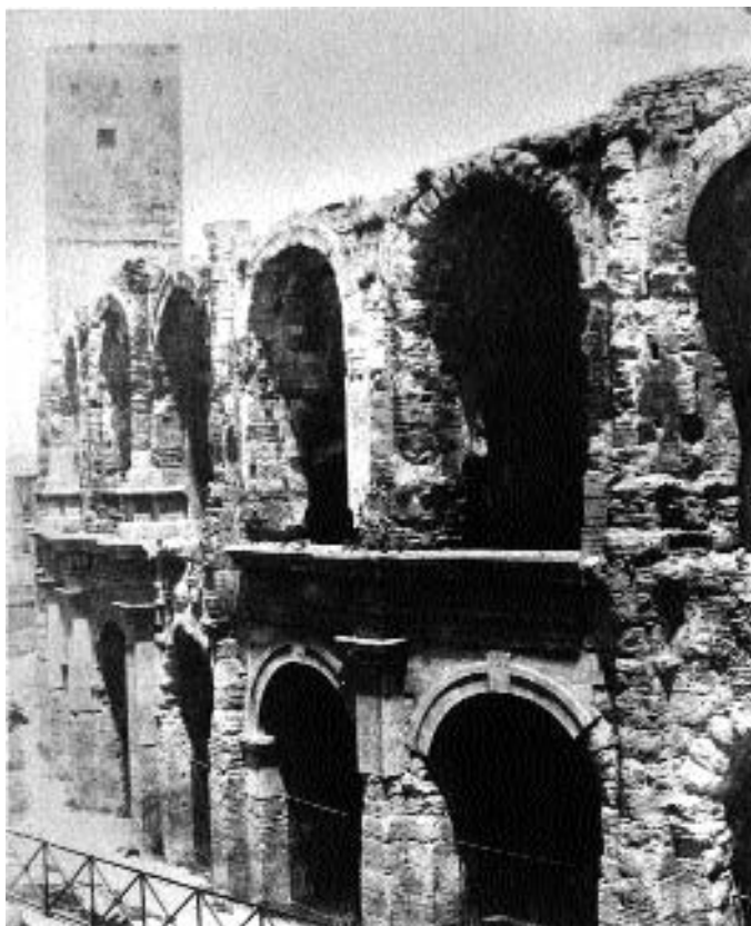
Fig. 308. Reprises partielles en pierres de taille sur la façade occidentale de l'amphithéâtre d'Arles, vers 1890. (Phot. Roman, fonds Gauthier-Descottes, méd. d'Arles.)
