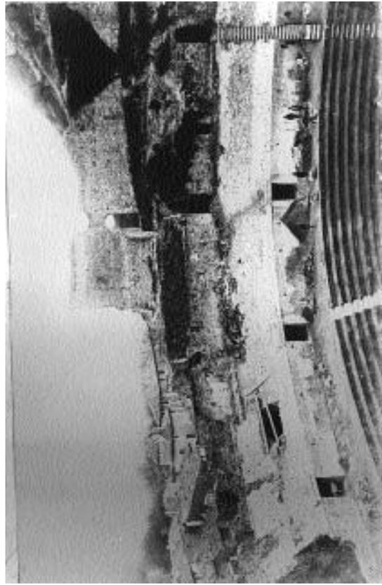
*Fig. 284 (a & b). La reconstruction du mur de praecinctio et des substructures destinées à recevoir les gradins du deuxième maenianum, 1900-1905. (Fonds privé Abel photo, Orange.)*
