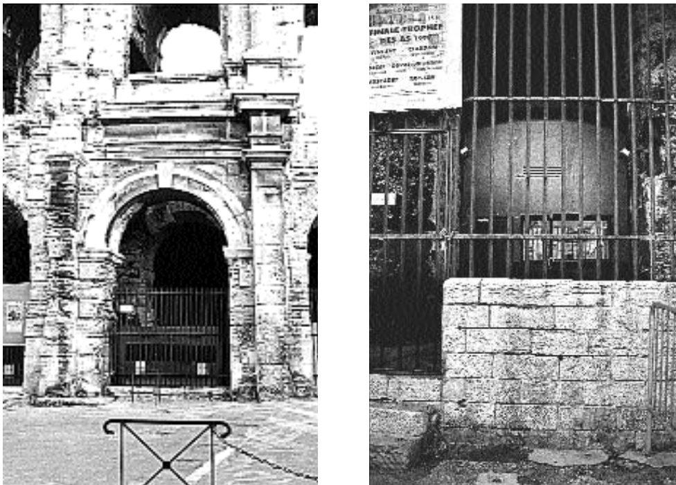
Fig. 513. Les différents baraquements tenant lieu de billetteries à l'amphithéâtre d'Arles, occupant la galerie extérieure du rez-de-chaussée sur trois travées à l'est de l'entrée nord. (Phot. V. Chevrier.)
