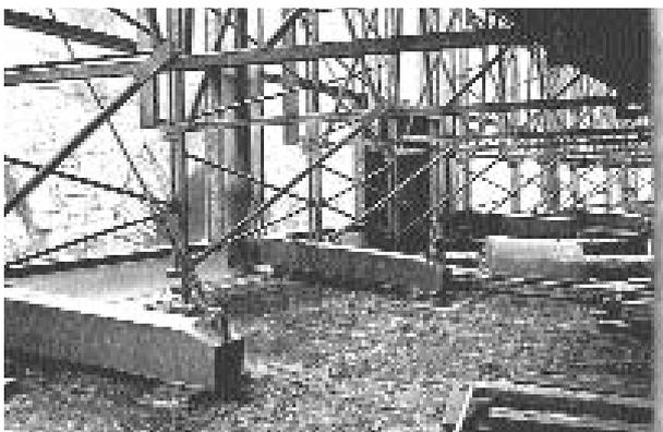
*Fig. 498. Scellements des éléments de l'ossature métallique soutenant les gradins des « secondes » de l'amphithéâtre de Nîmes et ceux des poutres de rive des plaques formant façade à l'arrière. (Phot. V. Chevrier.)*
