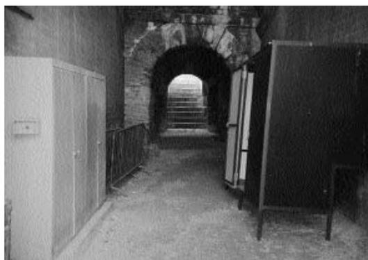
*Fig. 407. Diverses installations techniques à l'amphithéâtre d'Arles: porte de fer dans une baie d'origine, ou armoires électriques sur un socle de béton dans une travée du rez-de-chaussée. (Phot. S. Delarue.)*
