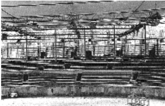
Fig. 466. Le gril scénographique suspendu au résille de câble de la lentille inférieure.
