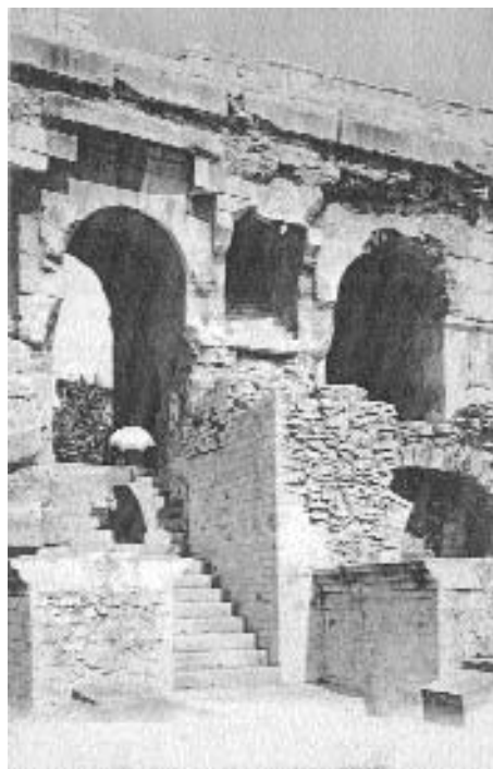
Fig. 303. L'un des escaliers principaux accédant à la galerie extérieure du premier étage de l'amphithéâtre de Nîmes, reconstruit partiellement en petit appareil de moellons smillés. (Carte postale, ND Phot., méd. de Nîmes, BM 153.)
