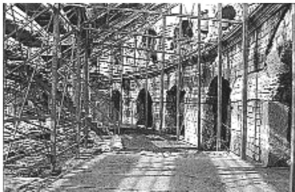
Fig. 488. L'emprise des échafaudages métalliques sur la galerie d'entresol de l'amphithéâtre d'Arles. (Phot. V. Chevrier.)
