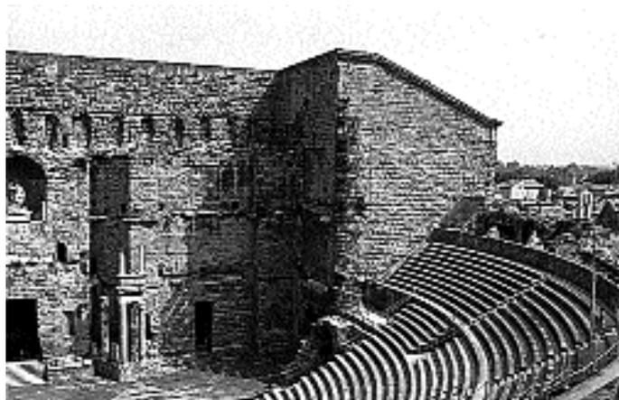
Fig. 479. Aménagement actuel de cinq rangs de gradins démontables contre le mur de la première praeinctio du théâtre d'Orange. (Phot. V. Chevrier.)
