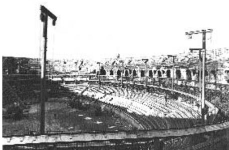
Fig. 456. Les grues manœuvrant sur la piste de l'amphithéâtre de Nîmes lors du chantier de montage de la « bulle », décembre 1988. (Nîmes. Le monument du spectacle, plaquette, 1988.)
