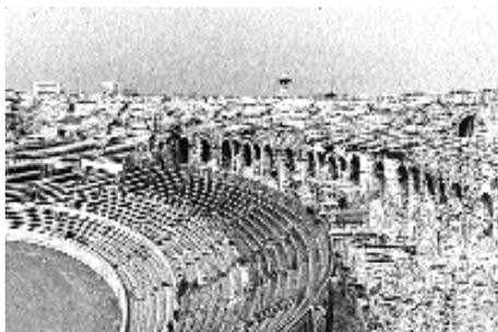
**Fig. 484.** Les degrés inférieurs des Arènes de Nîmes recouverts de planchards et les échafaudages en tubulure dressés en différents endroits dans les parties hautes. (Phot. Office du tourisme, Nîmes.)
