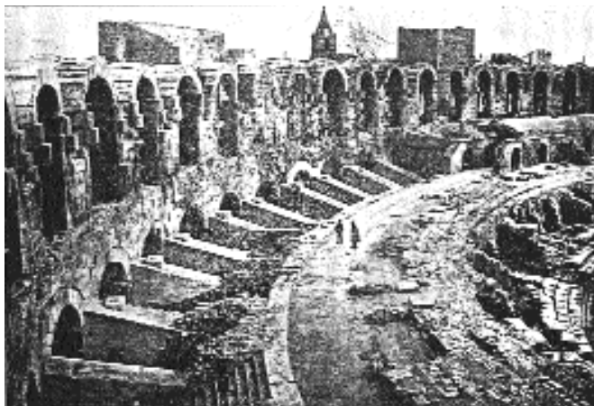
Fig. 300. Le nivellement des parties hautes de la cavea de l'amphithéâtre d'Arles, côté est, janvier 1876. (Carte postale, BP 43, fonds Flandreysy, Palais du Roure, Avignon.)
