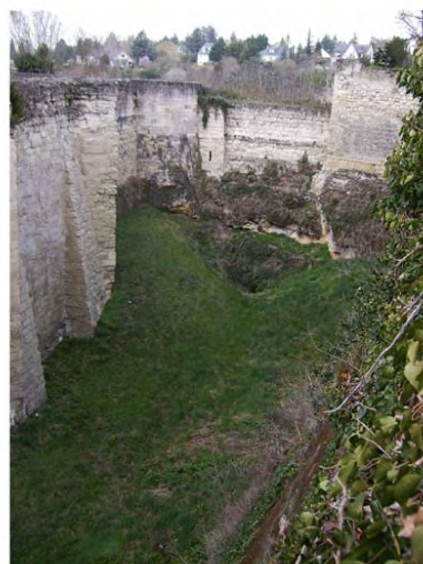
Photo 14 - vue d'ensemble de la douve avant travaux
