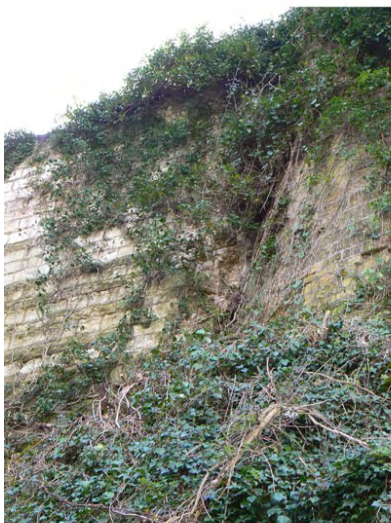
Photo 13 - vue externe de la courtine 5532, tour 5534 à droite et arrachement du contrefort 5530
