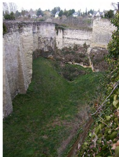
Photo 14 - vue d'ensemble de la douve avant travaux
