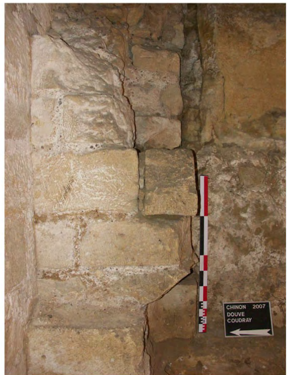
Photo 26 - détail de la face ouest du mur 5502
