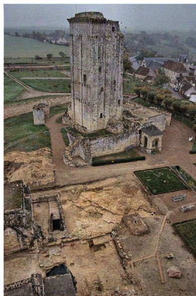
Photo 10 : vue d'ensemble prise de la tour Vironne à la fin de l'opération. Au centre, le massif rectangulaire dans la zone non fouillée correspond à l'emplacement de la tour d'angle octogonale abritant l'escalier d'accès au fossé transformé en caves à la Renaissance (phase IV).
