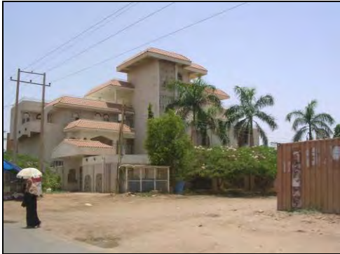
Photos 27 a, b et c : Les villas de Khartoum (quartier Amarat et Nord Omdourman)
