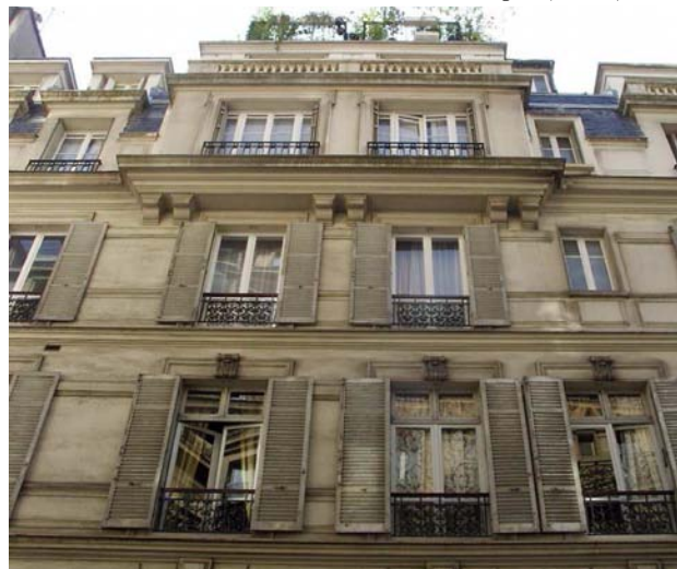
Immeuble haussmannien rue Saint-Dominique (7 e arr.)
