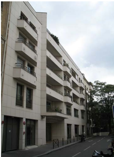
1 Immeuble de Toshiro (n°30), Villa des Entrepreneurs, (15 e arr.) : rue privée, parking en sous-sol.
