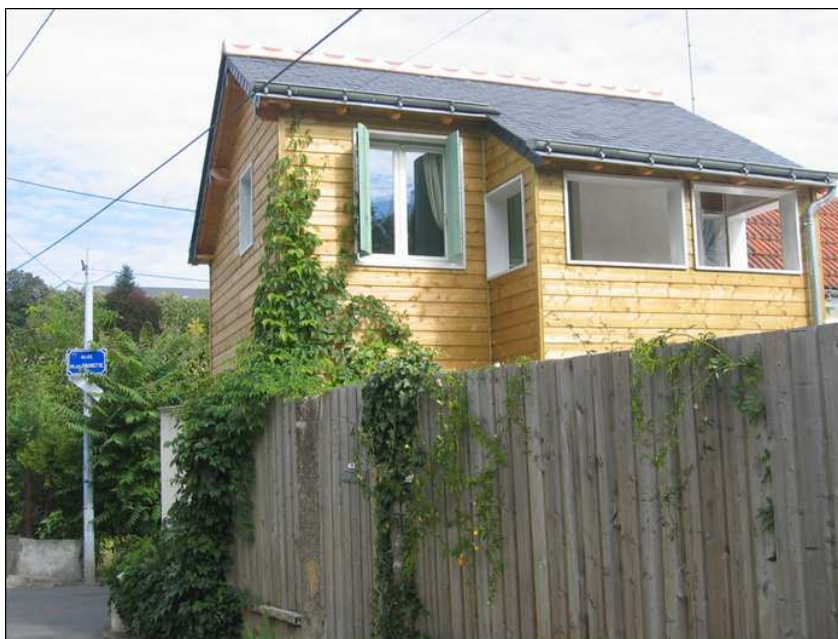
Photo 6.17 : Une construction neuve sur la Grande Ile Aucard à Tours : illustration d'une « illégalité tolérée » dans le lit endigué de la Loire
