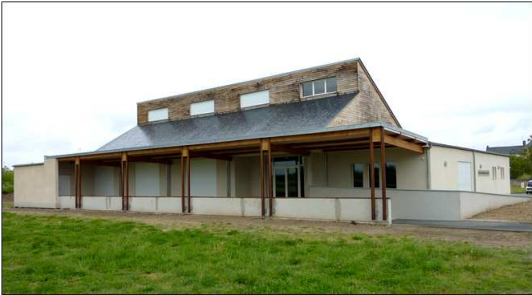
Photo 7.7 : Le centre de séminaires de Loire
