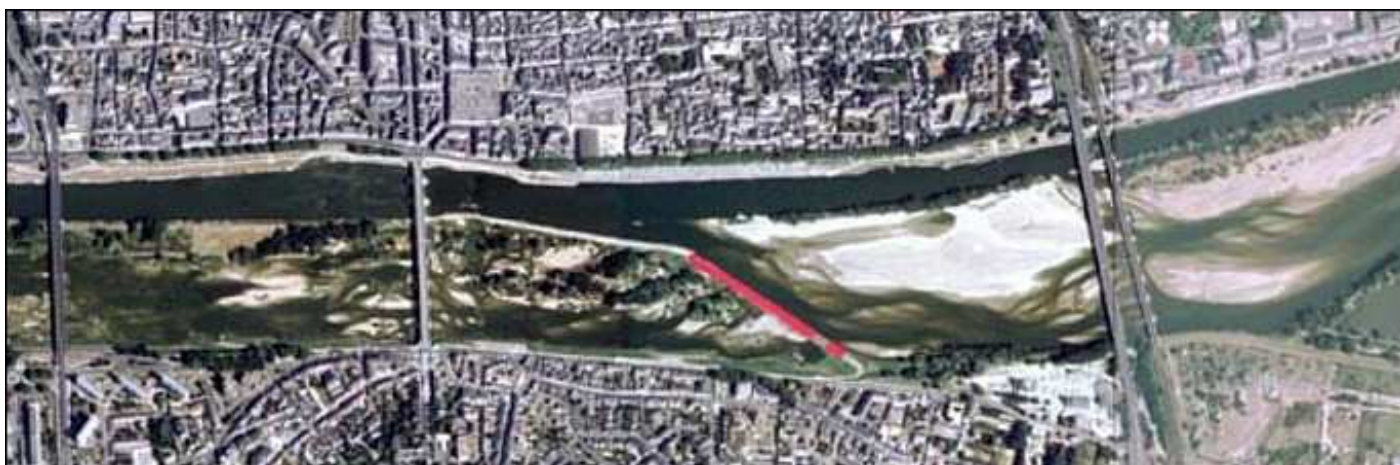
Photo 6.8 : Les aménagements prévus du duit Saint-Charles
