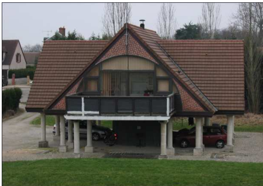
Photo 5.2 : A Saint-Pryvé-Saint-Mesmin, une maison adaptée au risque d'inondation
