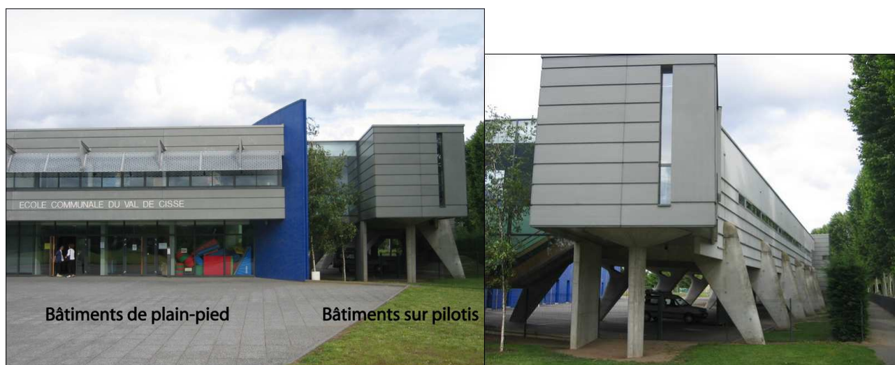
Photo 3.1 : A Nazelles-Négron, une école à l'architecture en partie adaptée à l'inondation
