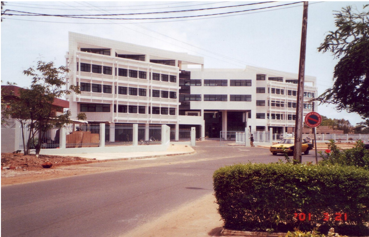
Photo 25. Nouvel immeuble administratif dans le quartier Les Ambassades à Fann. (Cliché Diawara A-B 2004)
