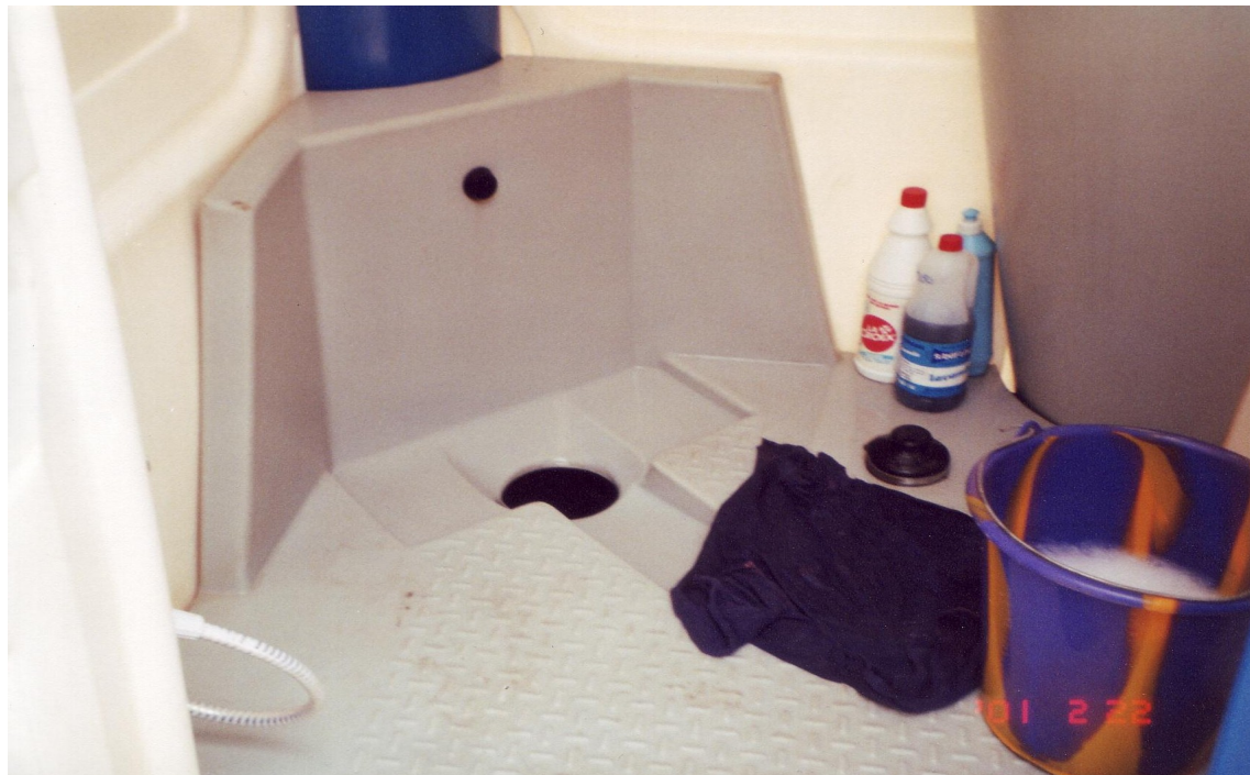
Photo 61. Intérieur des cabines avec des toilettes turques améliorées. Une arrivée d'eau avec pommeau au bout permet aux usagers de se laver les mains après utilisation. (Cliché DIAWARA A-B 2007)
