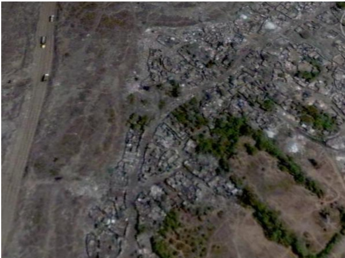
Photo 120. Image aérienne 12. Villages de récupérateurs installés sur le site de la décharge. (Crédit photo Google Earth 2009).
