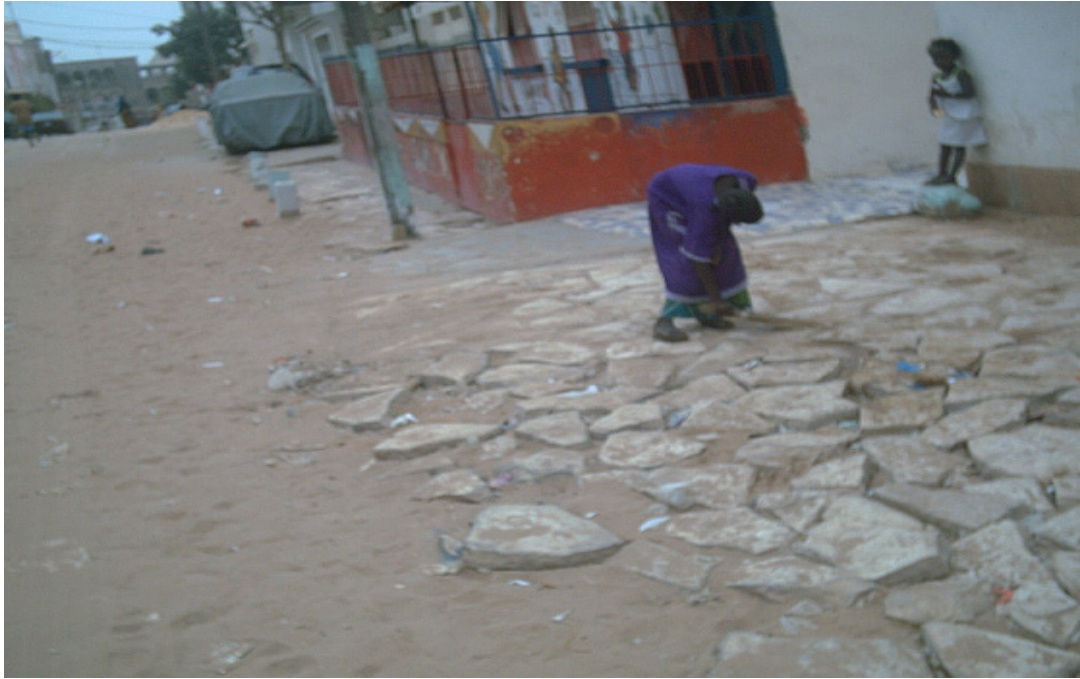
Photo 55. Espace attenant à la concession « gagné » sur le domaine public. Le trottoir « stabilisé » tout le long du mur extérieur de la concession fait office de terrasse alors qu'en arrière plan une clôture y est même érigée. Faisant désormais partie intégrante de la maison cet espace entretenu sera balayé tous les jours. Cette terrasse en phase de dégradation sera sans doute remise en état sous peu par les propriétaires. (Cliché DIAWARA A-B 2007 ).
