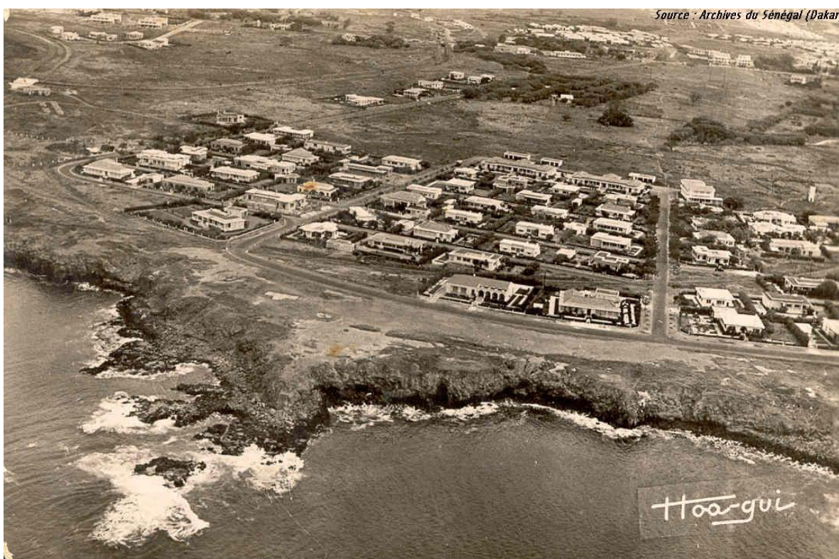
Photo 85. Le quartier de Fann vers 1945. Source Archives Nationales du Sénégal.
