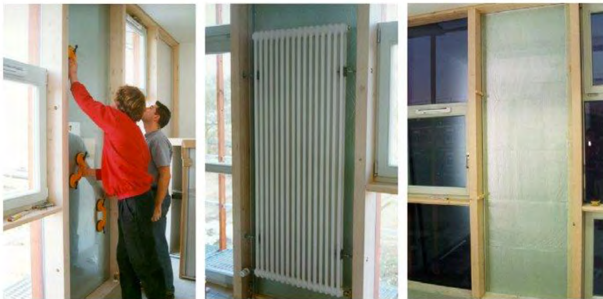
Figure 52 : Premiers tests d'intégration de PIV en 1998 sur le site du ZAE Bayern de Würzburg en Allemagne [Fricke, 2007]
