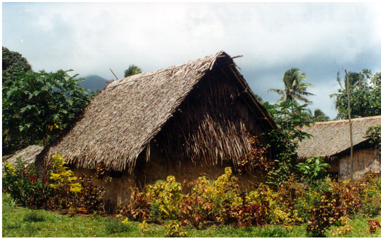
Photo 4 : Maison au toit en palmes de sagoutier et aux murs de bambous à Vētuboso (Source : S. Caillon 2001).
