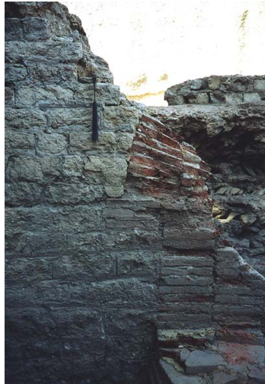
Fig.III.8. Départ de l'arc inclus dans le mur 3 des thermes de l'Esplanade, Arles.
