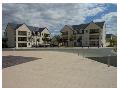
Figure 72. Les deux immeubles collectifs et la placette
