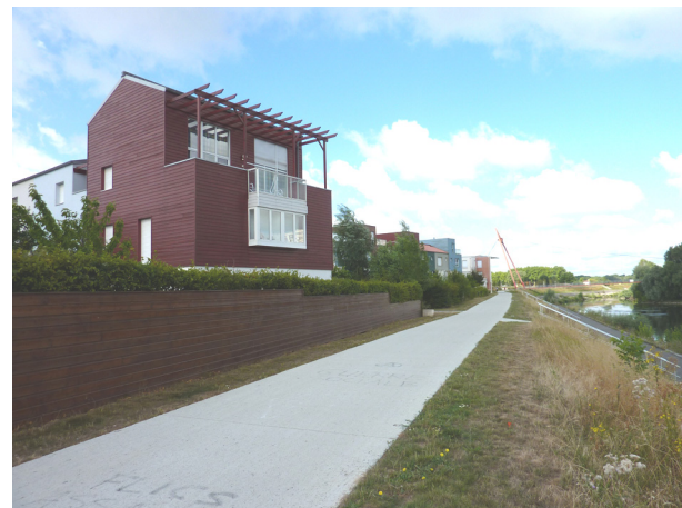
Figure 38. L'opération « Rive gauche » sur les bords du Cher (Réalisation personnelle, 2010)
