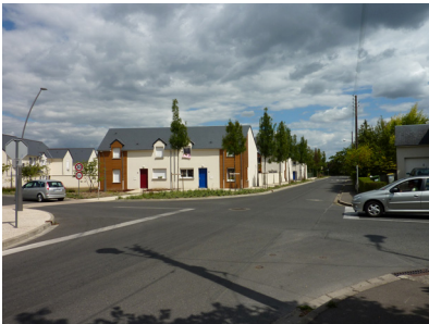
Figure 78. Les logements sociaux Nouveau Logis Centre Limousin
