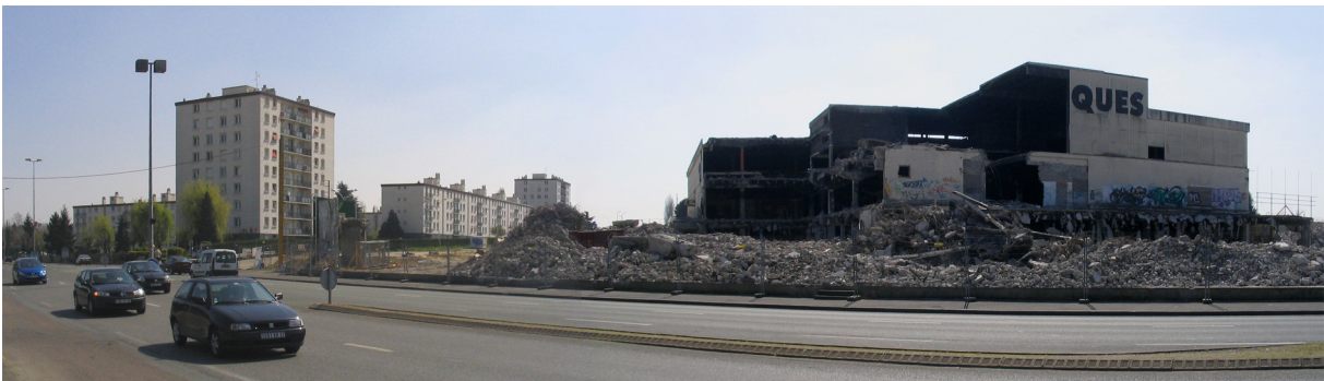
Figure 55. La résidence « Gallardon » et la friche « Rallye » (Mammouth) en cours de démolition, vues depuis l'avenue de la République, ancienne RN 143 (Réalisation personnelle, 2007).
