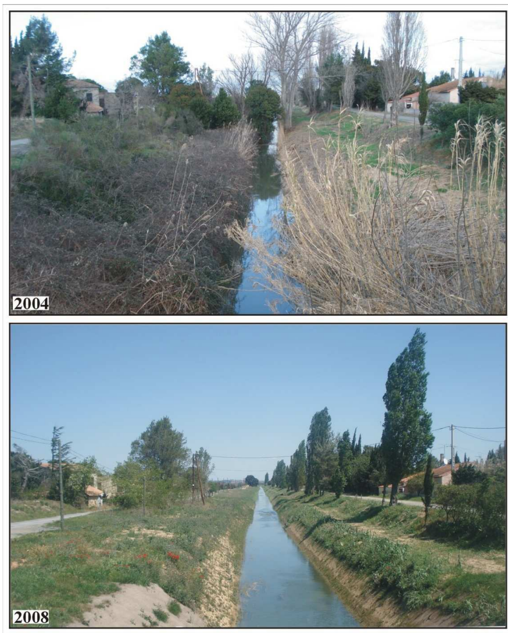
Photographie 5. 2 : Travaux de nettoyage sur le canal du Gailhousty
