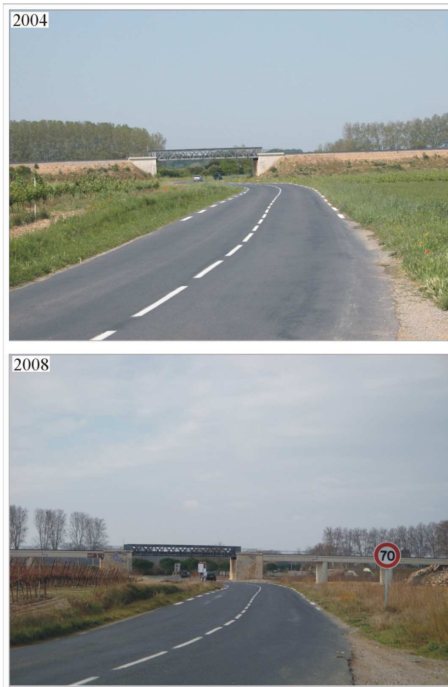
Photographie 5.3 : Remblai RFF avant (2004) et après (2008) travaux (Travaux de transparence hydraulique, Sallèles-d’Aude)
