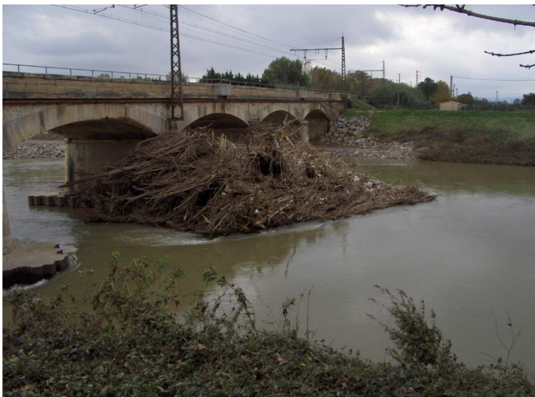
Photographie 5.1 : Accumulation de matériaux suite aux crues de novembre 2005, Pont SNCF, Coursan (Cliché : F Vinet, novembre 2005)
