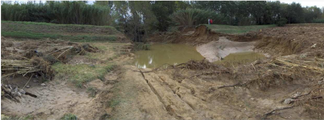
Photographie 6.9 : Brèche au Prat de Raïs lors des inondations de novembre 2005 (cliché : F. Vinet, 2005)
