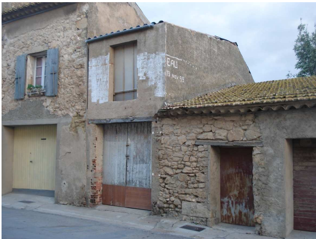
Photographie 4.1: Repère de crue de 1999 sur une habitation à Sallèles-d’Aude d’Aude. (Cliché S. Defossez).
