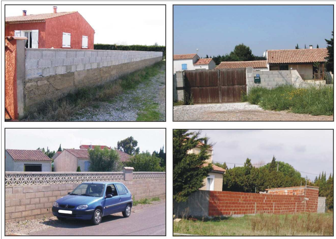
Photographie 7.2 : Exemple de clôture ne respectant pas la réglementation, Cuxac-d'Aude (Clichés : S. Defossez, 2004)
