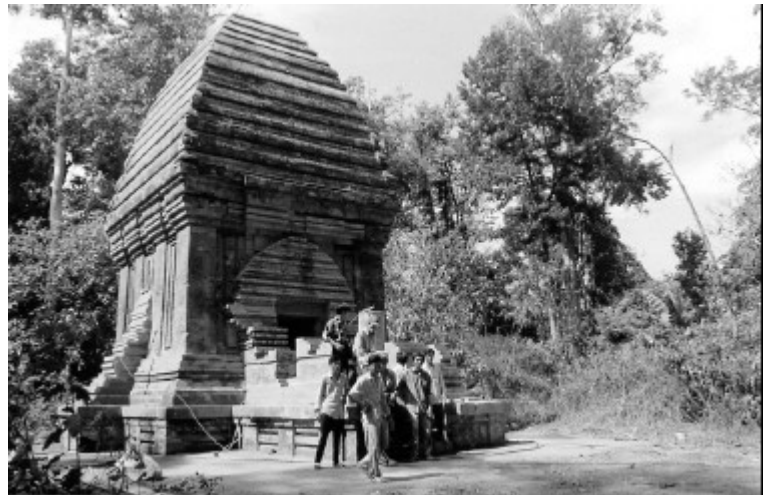
Photographie 1 La tour Cham en cours de restauration dans le district d'Ea Sup à Dak Lak
