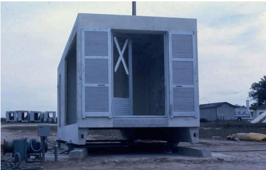
*Figure 4. Préfabrication à l'échelle du bâtiment*
