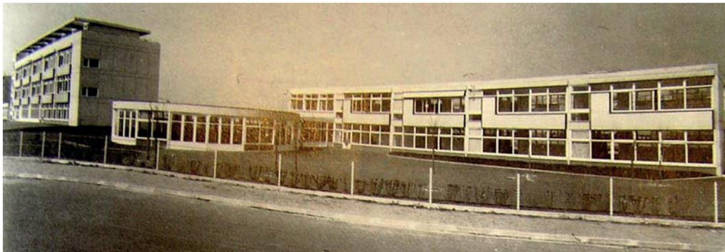
*Figure 34. Façades préfabriquées à Saint-Etienne du Rouvray*
