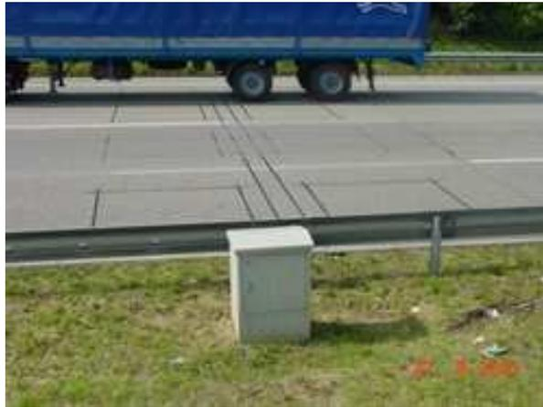
Figure 1.3 – Photo de boucles électromagnétiques (réseau OFROU, suisse).
