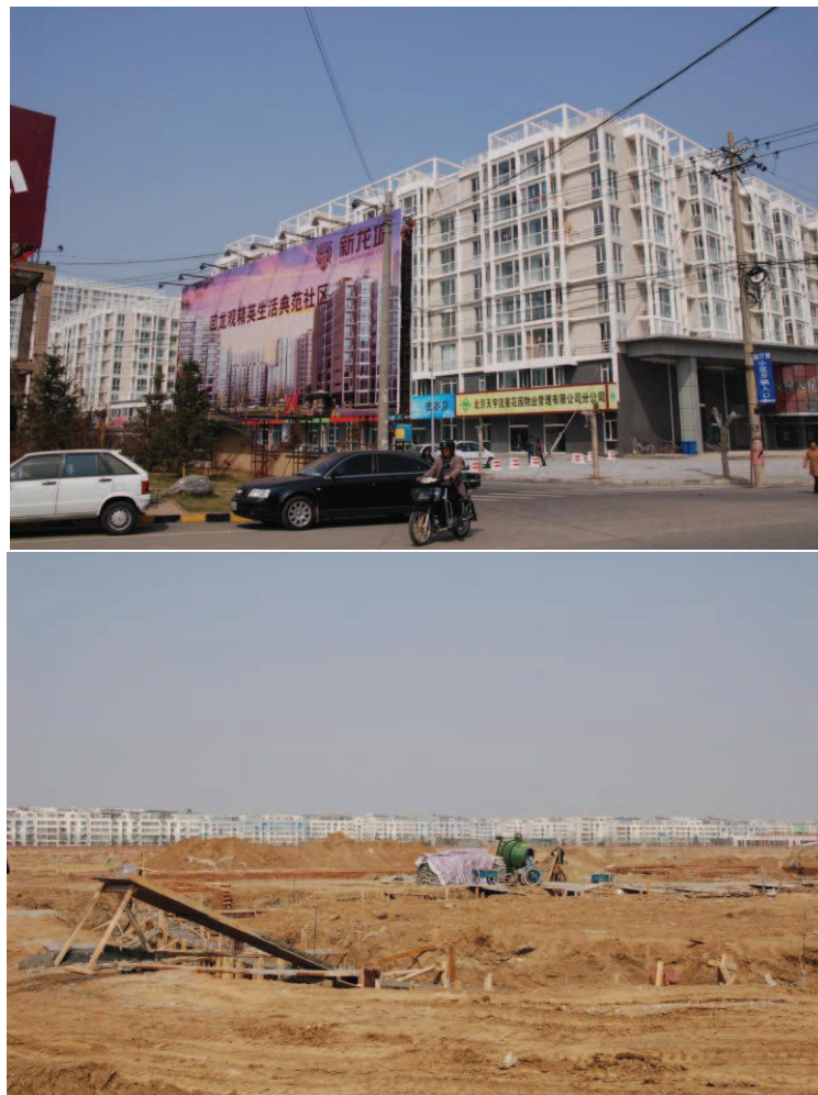
Cliché 14 – Beijing, un autre grand ensemble résidentiel des logements sociaux en accession, Huilongguan : logements construits et terrain à la construction, Liu K.
