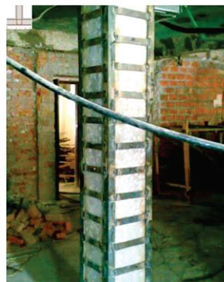
**Figure 1-32 : Confortement - Renforcement d'un poteau par plats métalliques.**
