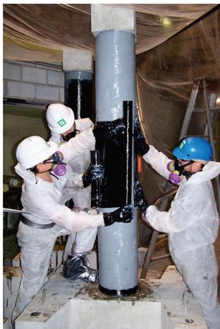
**Figure 1-34 : Confinement d'un poteau par TFC uniaxial.**
