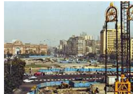
(Fig. 1.67) Les travaux en deuxième phase en face du musée du Caire
