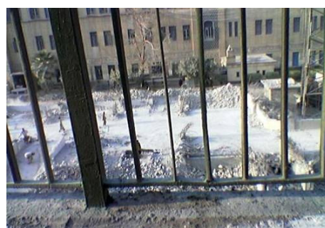
(Fig. 1.72) le site après la démolition du parking Source : El Gomhouriya
