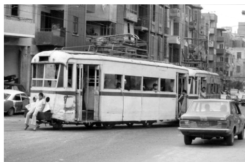
(Fig. 3.1) Dans les années 1980, avant la réalisation du métro, le tramway traversant le centre-ville.
