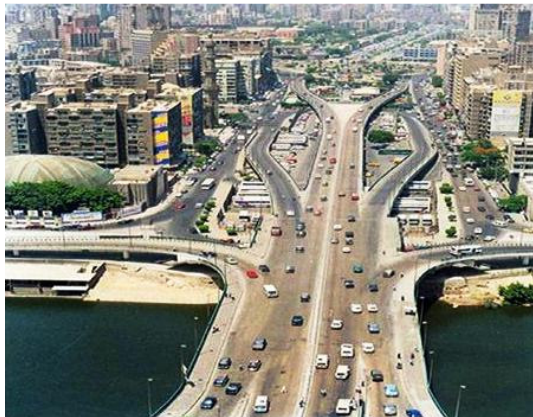
(Fig. 3.13) Le corridor du 26 Juillet se compose de 3 tronçons. Le premier démarre à la Place du Liban et se termine au croisement de la Route du Désert Cairo-Alexandrie. Le second part aussi de la place du Liban vers la place du Sphinx et comprend le passage inférieur sous la rue Wadi El-Nile. Le troisième tronçon joint la route surélevée du 6 Octobre à l'axe du 26 Juillet en passant au-dessus de la Rue du 26 juillet et par le pont du 15 Mai.
