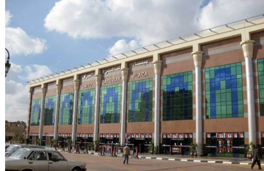
(Fig. 3.18) Le bâtiment principal de la gare internationale (Cairo Gateway Plaza) Source : Panoramio, Annette Luehsen
