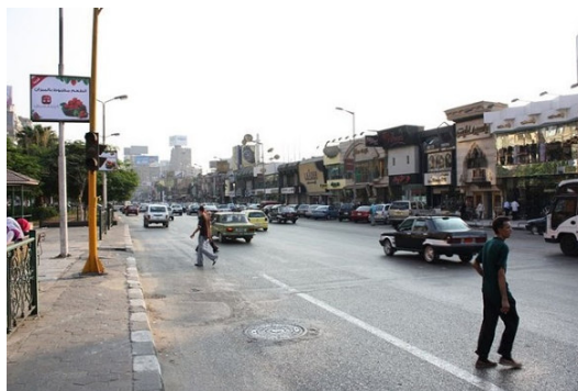
(Fig. 2.43) La muraille du club sportif Zamalek à Mohandessin qui a été transformée en boutiques pendant les années de l'Infitah Source : http://dvd4arab.maktoob.com/
