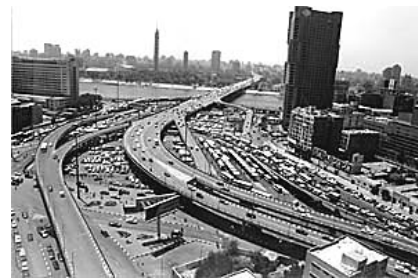
(Fig. 1.61) La place Abdel Moneim Riad pendant et après les travaux du pont 6 Octobre
