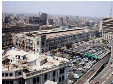
(Fig. 1.73) L'ancienne station de microbus devant la gare avant son déplacement Source : El Masry El Yom
