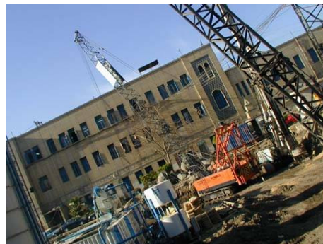
(Fig. 1.70) Les travaux du parking de Ramsès en face de la gare. Source : El Akhbar
