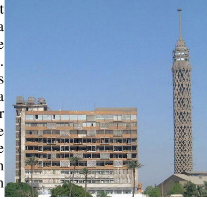
(Fig. 1.53) La Tour du Caire et à gauche de la photo, l'hôtel de la tour (El-Bourg) construit dans les années 1960 avec des façades laides qui reflètent l'orientation socialiste de l'époque, cet hôtel est encore en mauvais état aujourd'hui. Source : Samir Raafat
