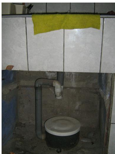
Photo n°98. Caisse de dégraissage permettant le fonctionnement des systèmes semi-collectifs communautaires, Carabayllo 2008
