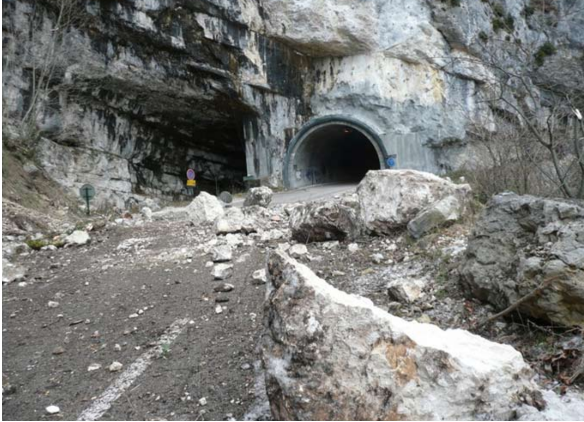
FIG. 1.1: Photographie prise après l'éboulement du 16 Janvier 2009 à l'entrée du tunnel d'Arbois dans les gorges de la Bourne, Vercors ( http://forum.vercors.org/viewtopic.php?f=19&t=901&start=300 ). Picture took just after the 16/01/2009 rockfall in front of the "Arbois" tunnel (Gorges de la Bourne, Vercors).
