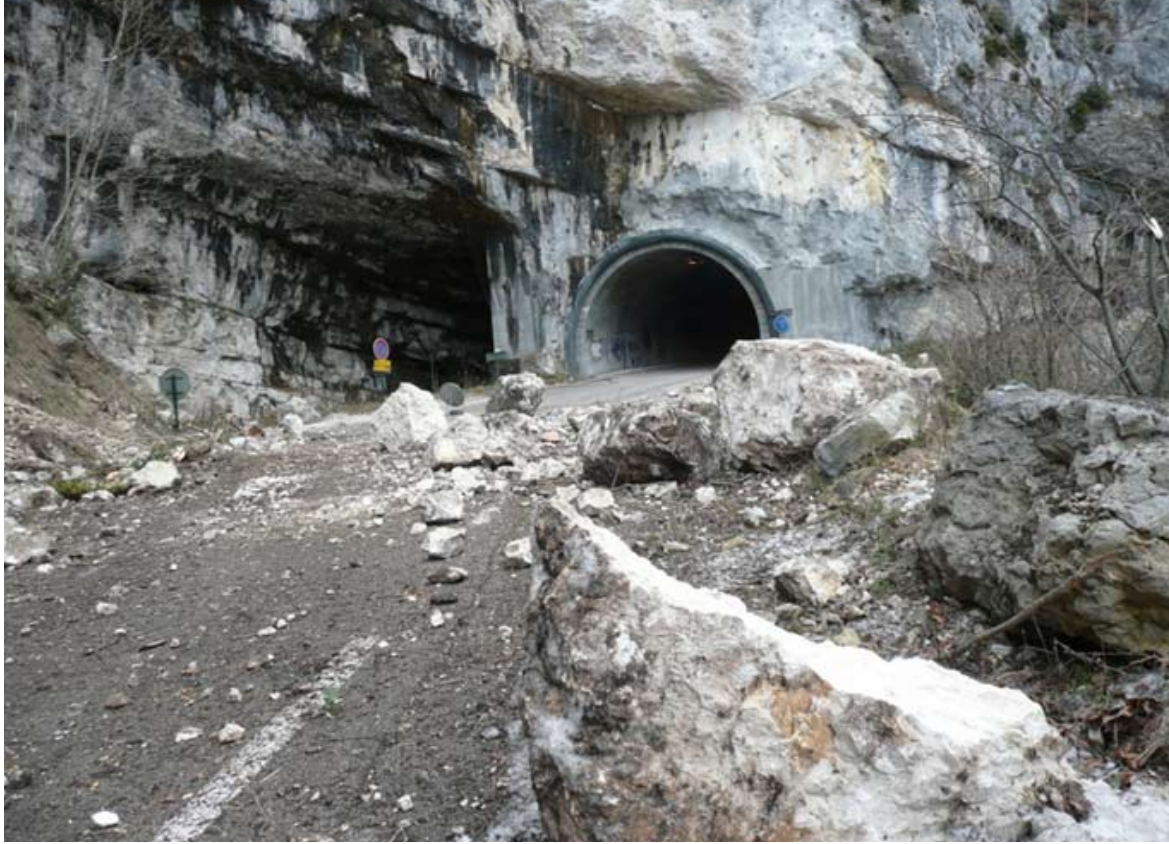
FIG. 1.1: Photographie prise après l'éboulement du 16 Janvier 2009 à l'entrée du tunnel d'Arbois dans les gorges de la Bourne, Vercors ( http://forum.vercors.org/viewtopic.php?f=19&t=901&start=300 ). Picture took just after the 16/01/2009 rockfall in front of the "Arbois" tunnel (Gorges de la Bourne, Vercors).
