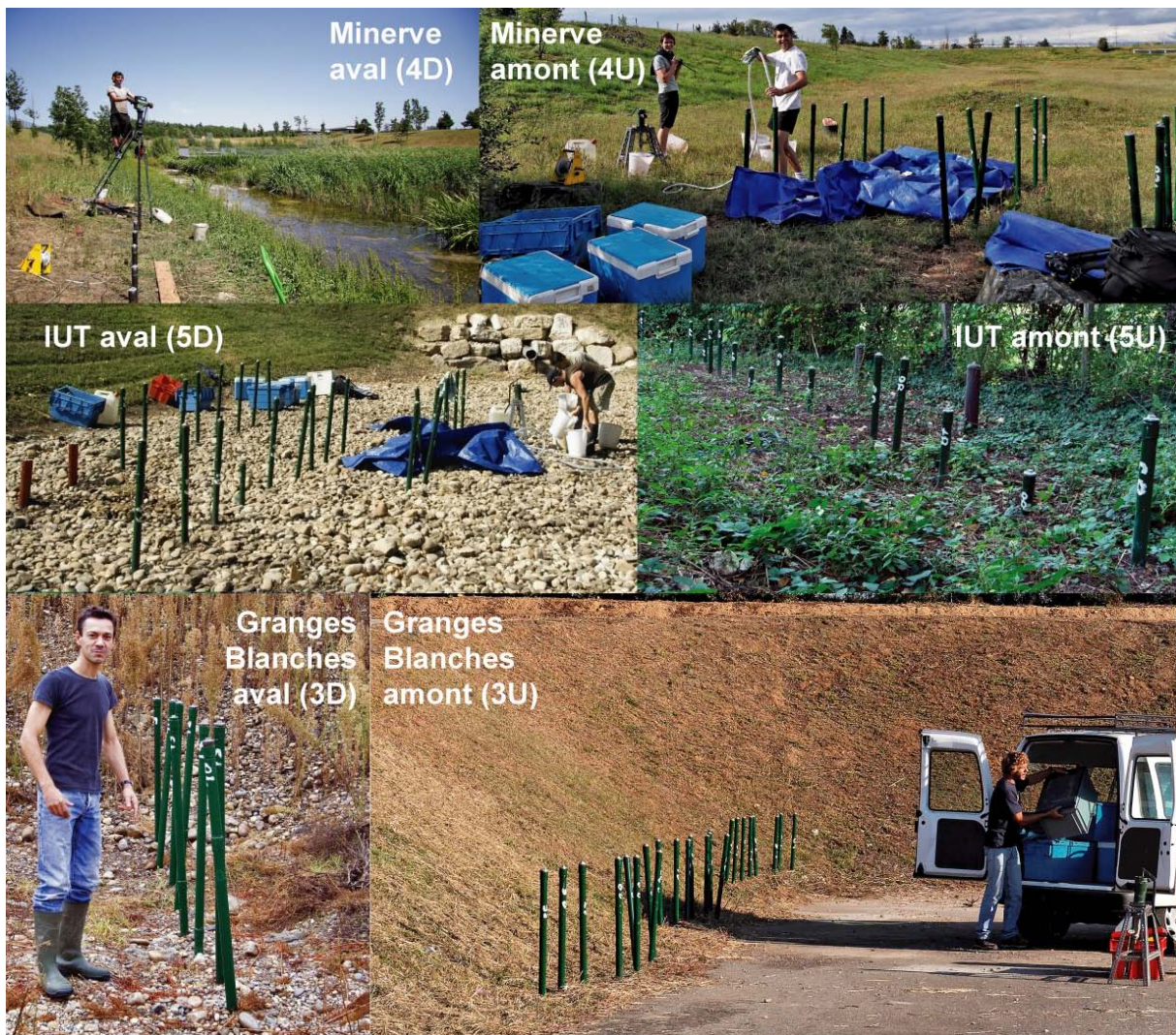
Figure 2.4: Installation des batteries de piézomètres en flûtes de pan aux sites 3 (Granges Blanches), 4 (Minerve) et 5 (IUT).
