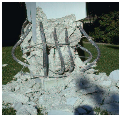
FIGURE 1.2 – Poutre en béton armé en compression : ruine par flambement et rupture fragile.
