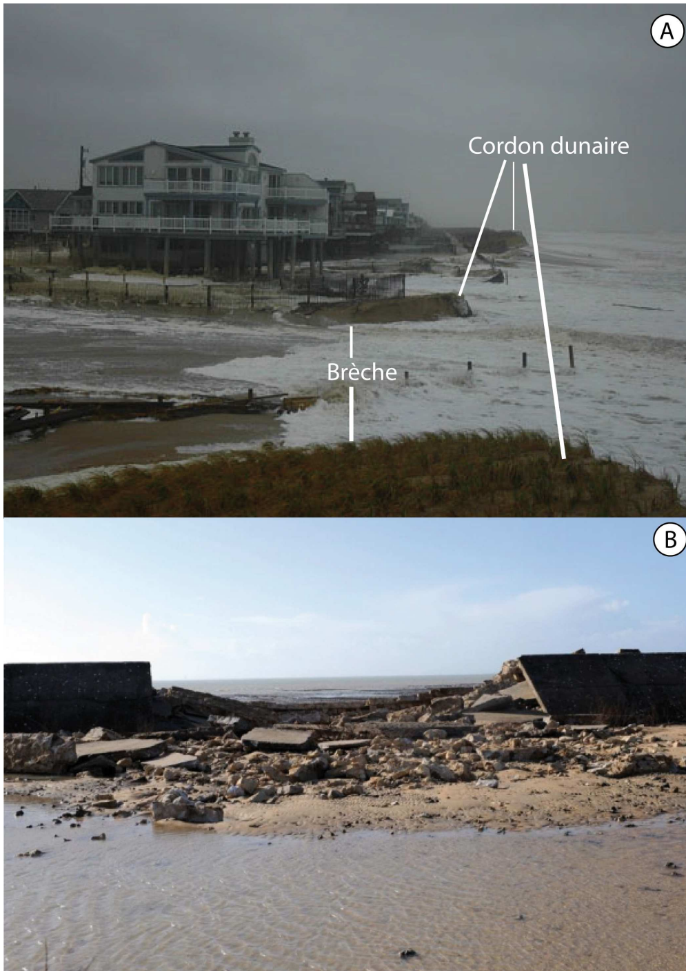
Photo 5. A : Ouverture de brèches dans un cordon dunaire à South Bethany, côte du Delaware aux Etats-Unis, le 13 novembre 2009 (source : site internet de l'état du Delaware 7 ) ; B : Brèche ouverte dans une digue à l'île de Ré, après le passage de la tempête Xynthia (source : Le Figaro, le 01/03/2010).
