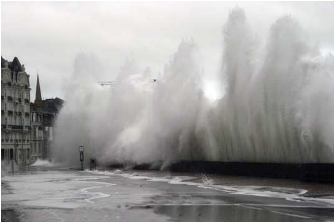
Photo 8. Phénomène de franchissement au niveau de la digue du Sillon, à Saint-Malo, le soir du 10 mars 2008.
