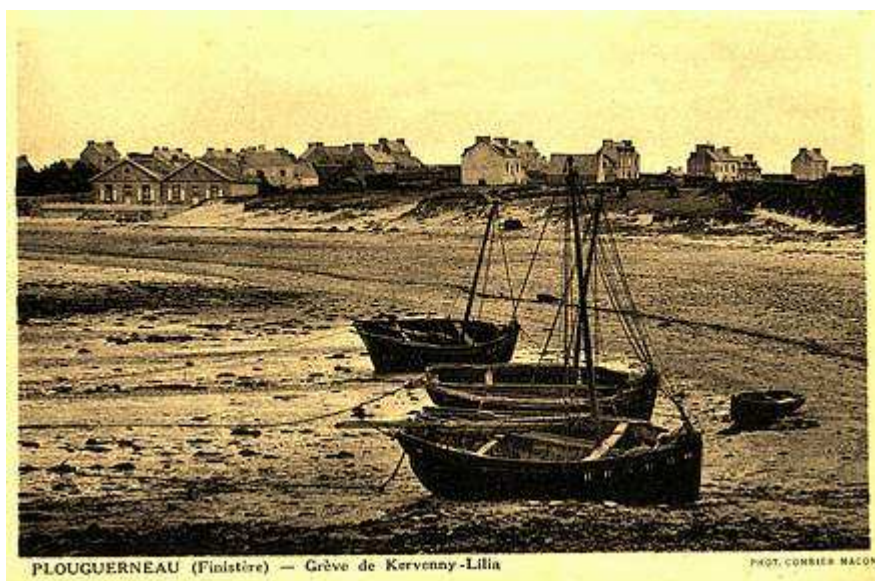
Photo 24. Cordon dunaire de la plage de Kervenni avant la construction du perré en 1964.
