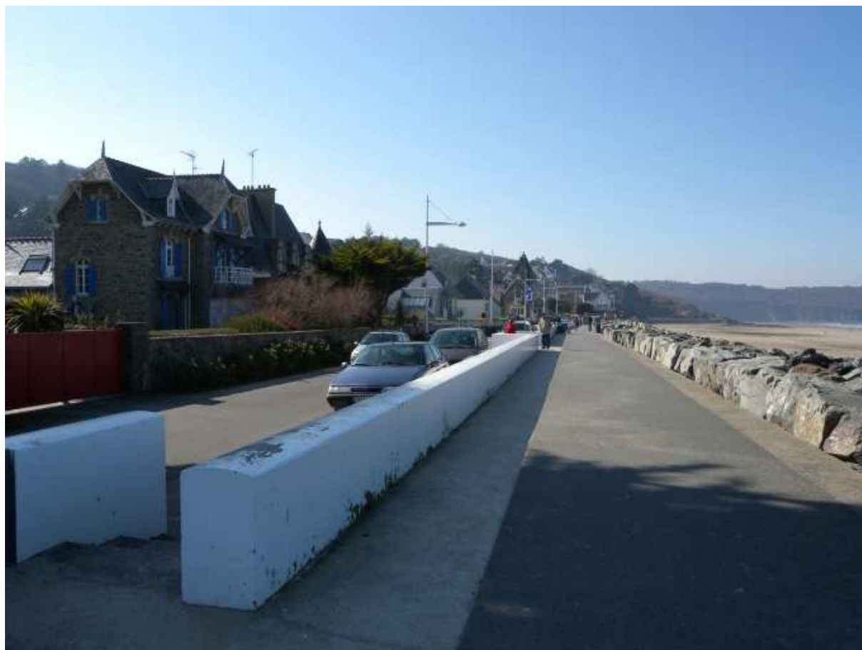
Photo 9. Enrochement et chaussée de rétention d'eau construite en 2001 le long du front de mer aux Rosaires, Plérin (cliché : G. Prigent).
