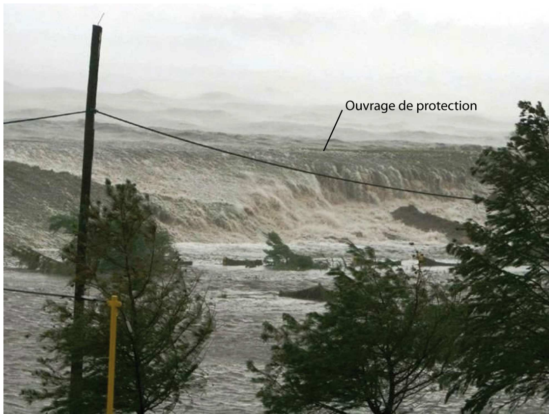
Photo 4. Phénomène de débordement durant le passage de l'ouragan Katrina, le 29 août 2005, dans la baie de Saint-Louis, Nouvelle-Orléans. Quelques minutes après le débordement observé sur ce cliché, l'ouvrage de défense a rompu (photo : Don McClosky).
