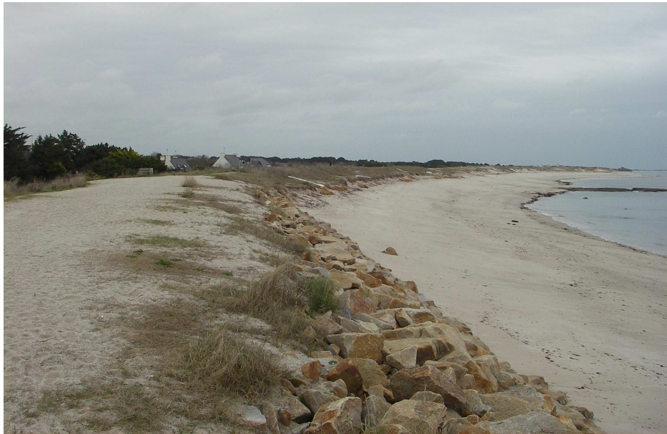
Photo 10. Enrochement longitudinal sur la plage de Lehan (Treffiagat).
