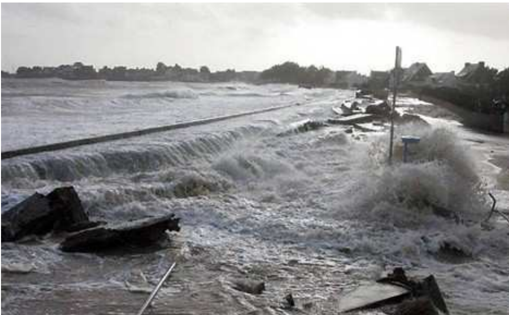
Photo 14. Submersion et ouverture de la brèche au niveau de la digue de la Grande Plage à Gâvres le 10 mars 2008 (source : Ouest France).
