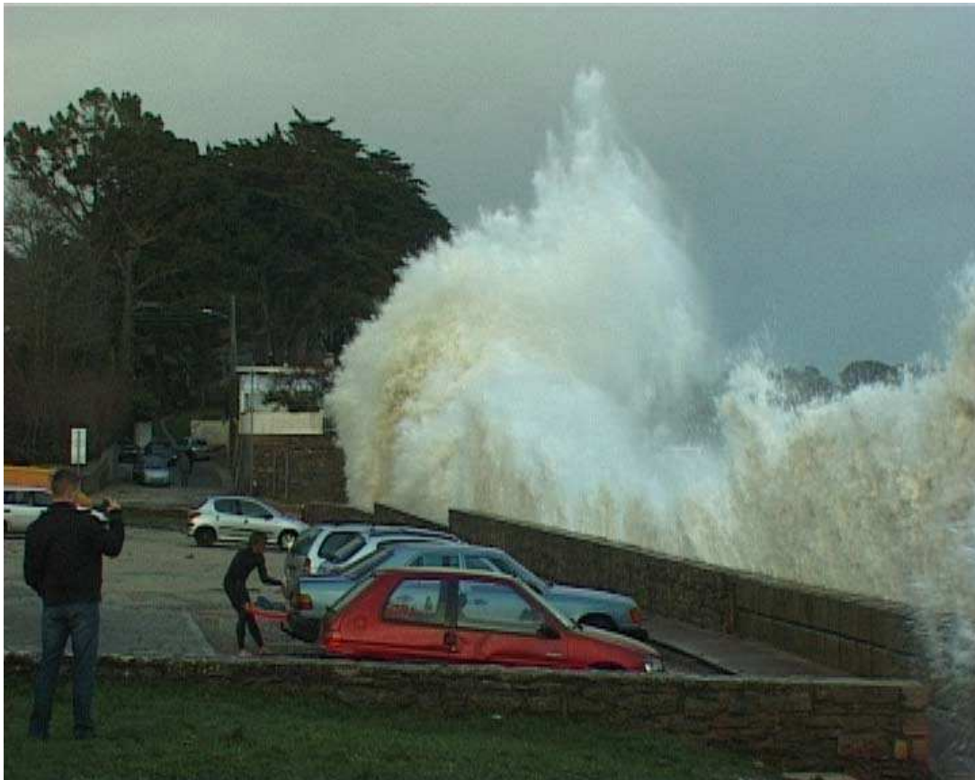
Photo 6. Phénomène de franchissement par « paquets de mer » amplifié par la présence d'un perré. Le 10 mars 2008 sur la plage du Trez Hir à Plougonvelin (Cliché : R. Gladu).
