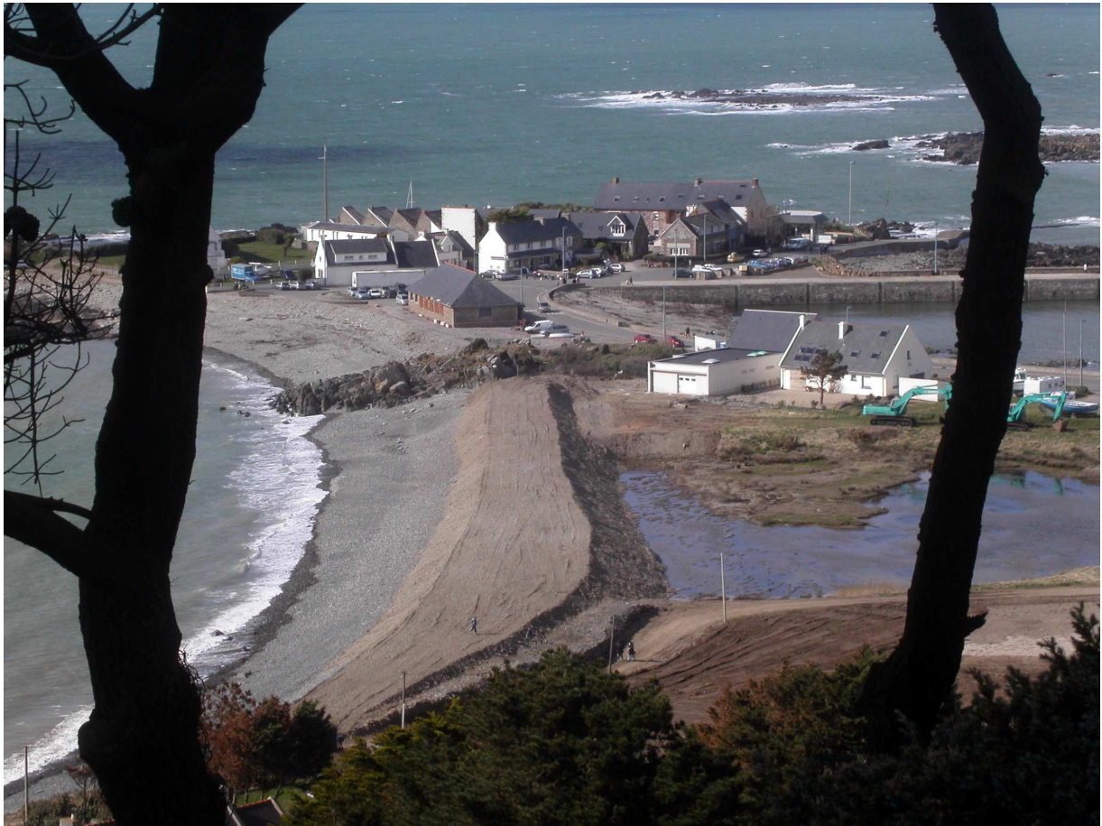
Photo 21. Le cordon de Pors an Ero Vili, reprofilé et exhaussé après sa submersion en mars 2008 (cliché : J. Le Jeune).
