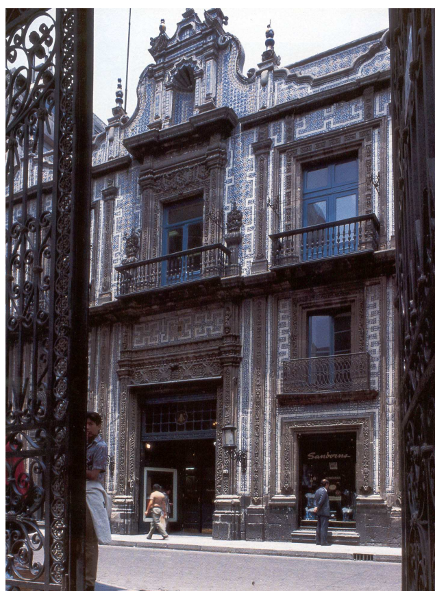
Photo 4-13 : La casa de los Azulejos, rue Madero (sources : guide CH, 1996)
