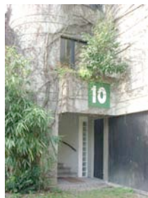
Hiver 2004-2005 Cage d'escalier des 1 er et 2 e étages
