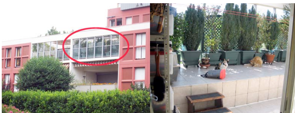
n°11 JOSETTE Der/2, 2e, Salon+Chambres, G3 À gauche vue sur le jardin depuis l'espace public, à droite vue depuis le logement
