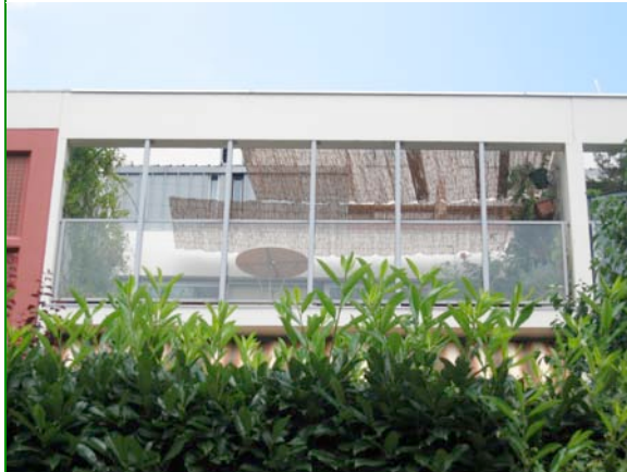
Eté 2007 Vue sur la façade sud depuis le chemin piéton
