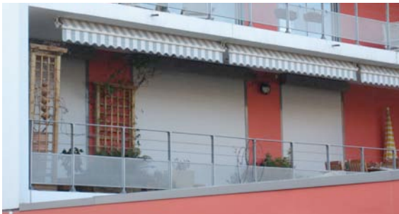
Hiver 2006-2007 Vue sur la loggia depuis une rue adjacente
