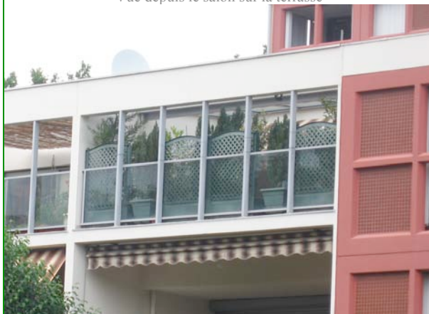
Été 2007 Vue sur la façade sud depuis le chemin piéton
