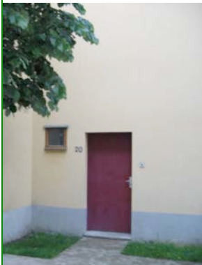
Porte sur venelle donnant accès au logement
