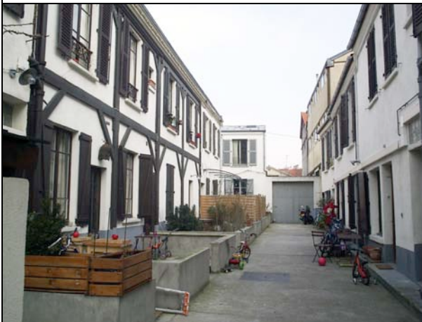
Vue sur la venelle depuis le portail d'entrée
