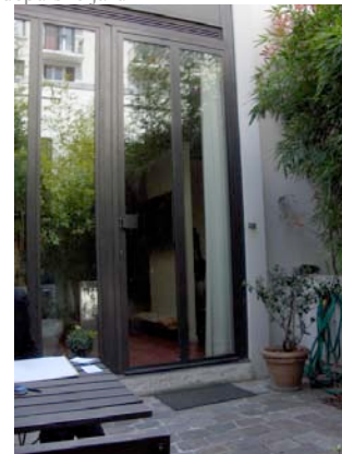
Vue sur la porte d'entrée depuis l'entrée du jardin
