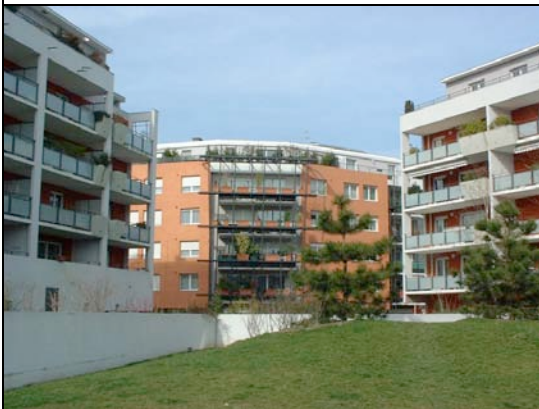
Printemps 2004 Façade sud vue depuis une copropriété voisine
