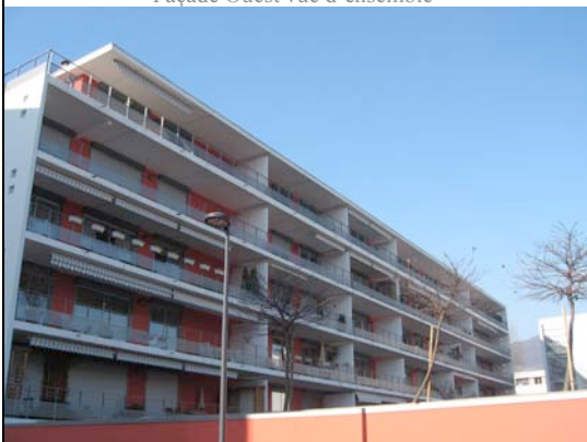
Hiver 2006-2007 Façade Est donnant sur la toiture végétalisée des parkings
