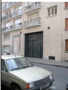
Porte d'entrée sur rue
