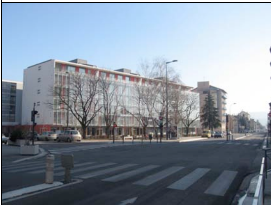
Hiver 2006-2007 Façade Ouest vue d'ensemble
