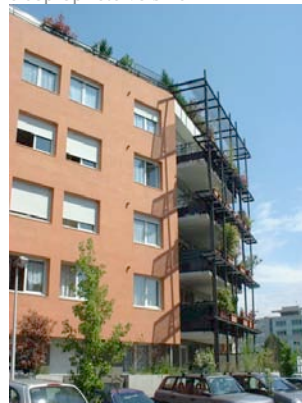
Printemps 2004 Partie centrale Vue Sud
