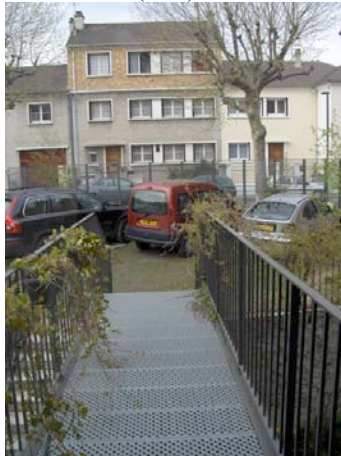
Vue depuis la porte d'entrée du logement sur la passerelle jardin de devant en direction du parking et de la rue
