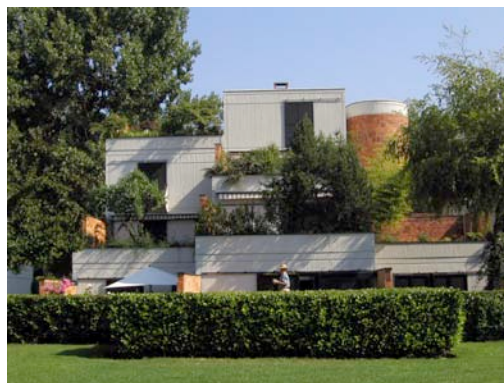
Terrain G7 disposition en gradins des logements et de leur(s) jardin(s)
