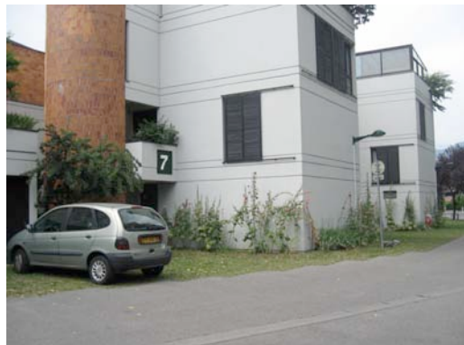
n°30 EGLANTINE PatDer, 1er, Extérieur, G7 (Eglantine habite au 1er étage et jardine des roses trémières le long des murs en RDC)
