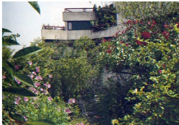
Vue depuis la grande terrasse niveau haut 96
