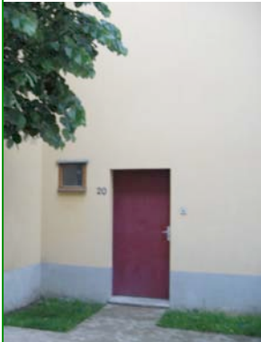
Porte sur venelle donnant accès au logement
