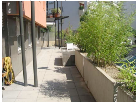
Été 2007 Vue depuis la terrasse en direction de l'Est
