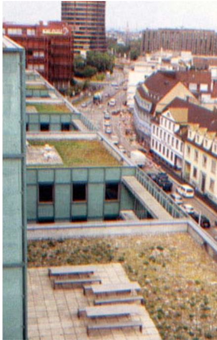
Toits « bruns » sur le centre de tri postal de Bâle (Suisse) 39
