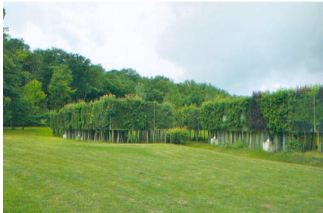
Gîtes ruraux, 10 logements de vacances, Jupilles (72), 1997 par Edouard François et Duncan Lewis & associés 65
