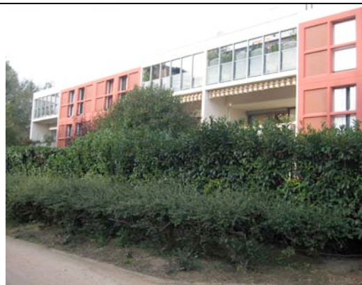
Vue sur la façade Sud depuis le cheminement piéton qui borde les jardins de pleine terre en rez-de-chaussée
