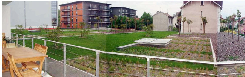
Printemps 2005 Vue depuis la loggia sur la toiture végétalisée des parkings
