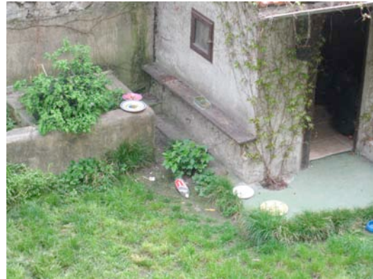
Zoom sur les gamelles des chats qui traînent... et sur le cabanon privatisé par un des logements du rez-de-chaussée pour entreposer des poubelles (le local poubelle se trouve dans la cage d'escalier)
