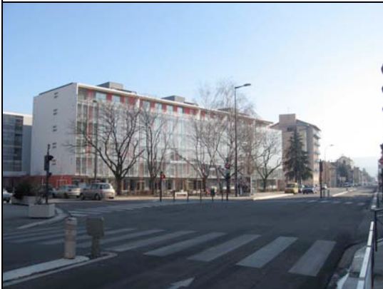
Hiver 2006-2007 Façade Ouest vue d'ensemble
