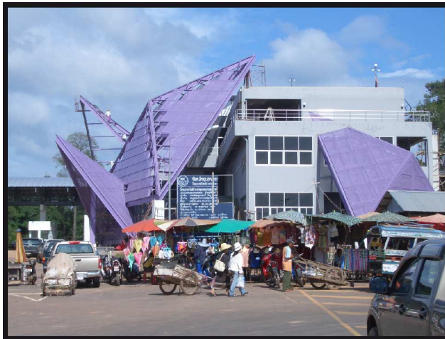
Photo 30 – Bâtiment des douanes en construction, Chong Mek, Thaïlande
