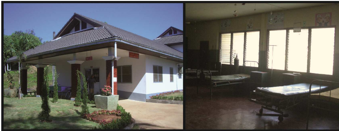
Photo 14 - Hôpital provincial de Houayxay (Laos) : contraste entre des locaux récemment construits et des chambres d'hospitalisation désertées
