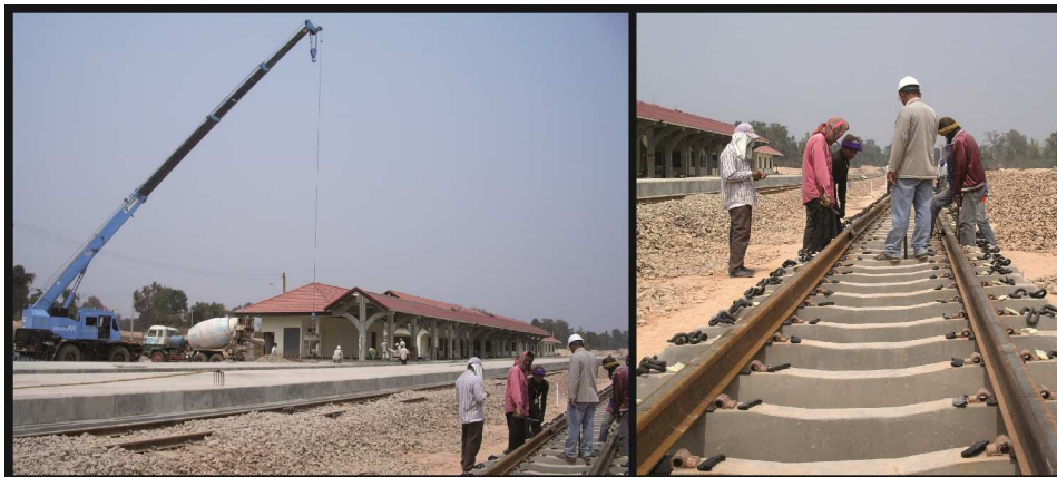
Photo 3 – Construction de la gare et de la ligne de chemin de fer, Vientiane, mars 2008.
