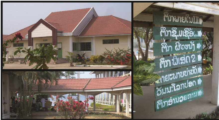
Photo 24 - Bâtiments rénovés de l'hôpital provincial de Savannakhet
