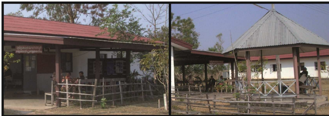
Photo 32 - Hôpital de district de Phonthong, Laos
