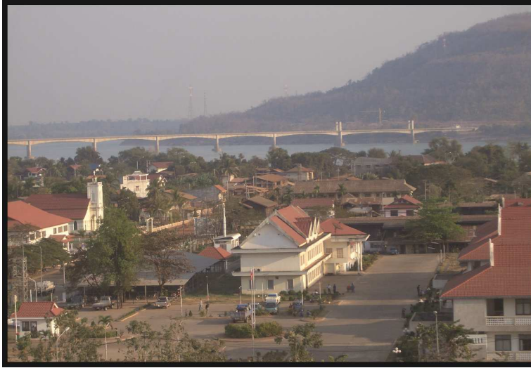
Photo 25 - Le pont construit avec la coopération japonaise à Pakse, Laos
