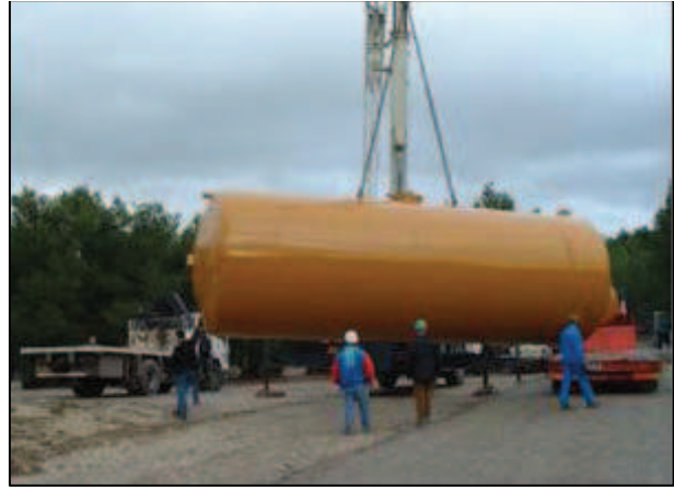
Fig. 70 : Pose d'une citerne
