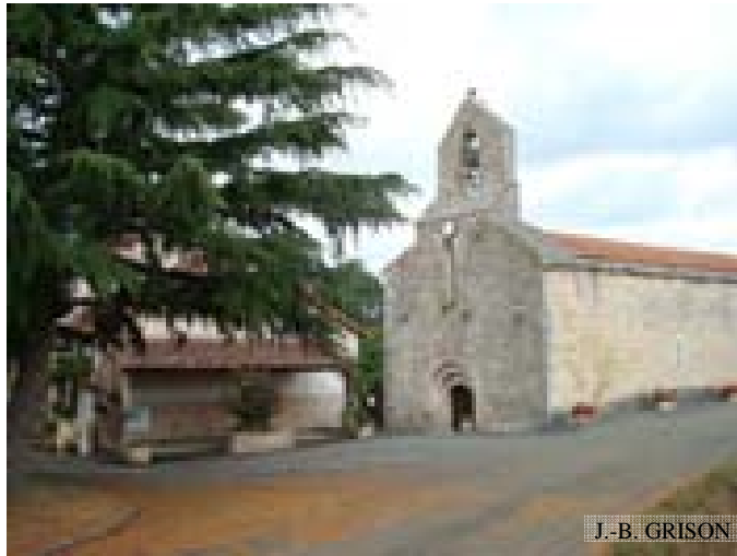
Photographie n°1 : place de l'église. (07.08.2008, vers le nord).
