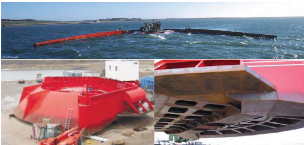
FIGURE 1.11: Wave Dragon, système offshore flottant, en haut : vue d'ensemble avec les bras réflecteurs, en bas à gauche : vue de la rampe de déferlement et du bassin de remplissage, en bas à droite, vue des compartiments permettant d'ajuster la hauteur de flottaison [Kofoed06, Cruz08]
