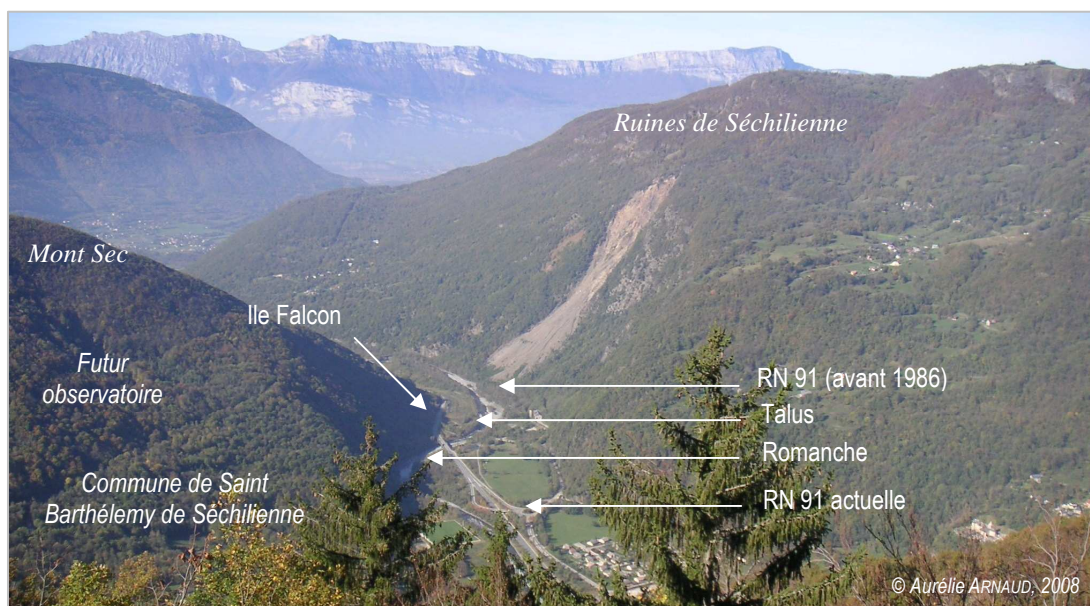
Photographie 3 : Eboulement des Ruines de Séchilienne (38)
