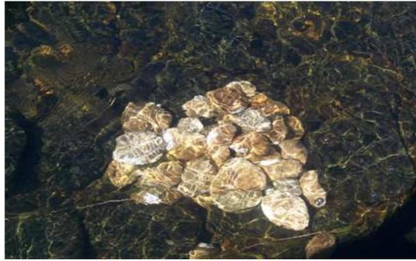
FIGURE 6.30: Mise en place des graviers en cluster dans le lit du fleuve.
