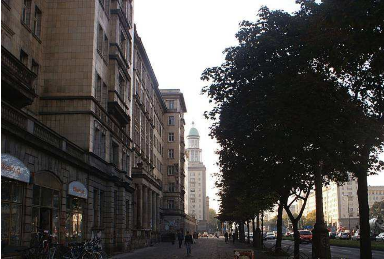
Figure 4 : Bâtiment le long de la Frankfurter Allee .
