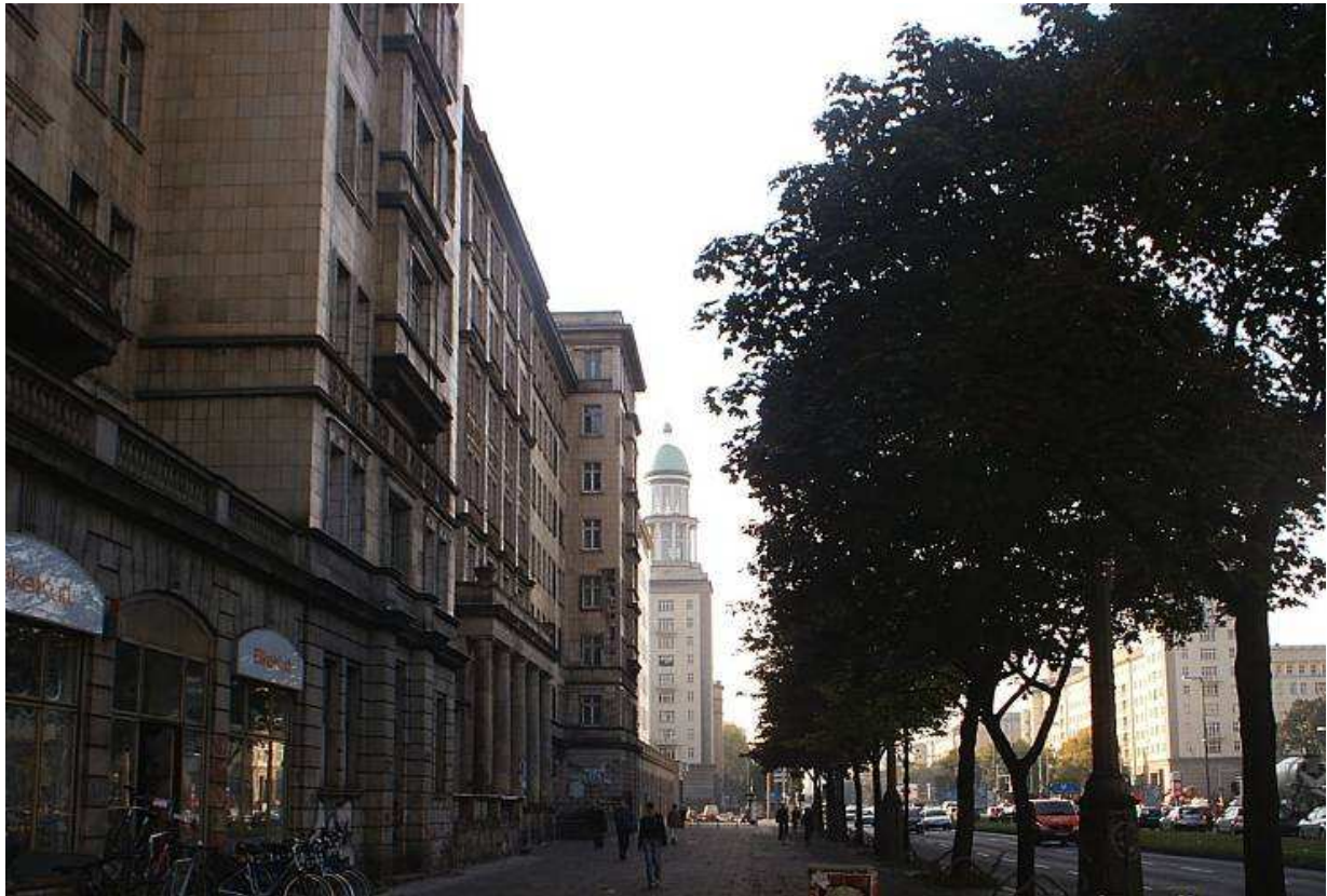
Figure 4 : Bâtiment le long de la Frankfurter Allee .
