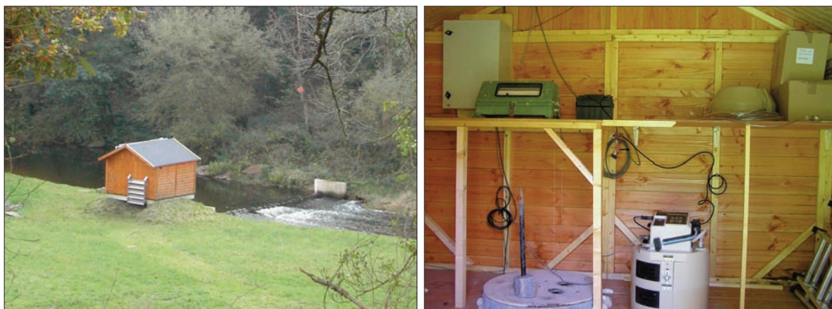
Planche photo 11. Station hydrométrique du Pont de Brec'h située sur le cours principal du Loc'h à l'amont immédiat de la retenue de Tréauray
