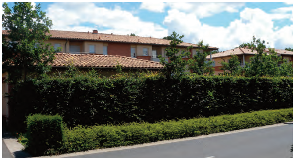
42d. La clôture végétale et derrière les bâtiments
