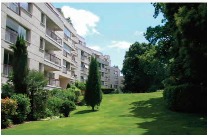
38d. Les bâtiments et le parc
