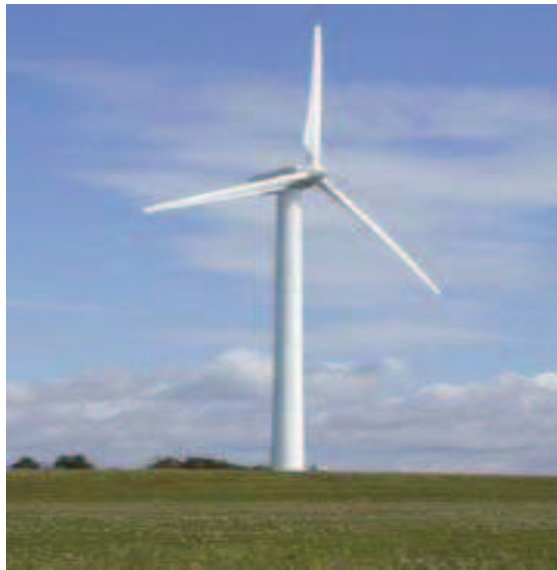
Fig. I. 4 : Aérogénérateur à axe horizontal.
