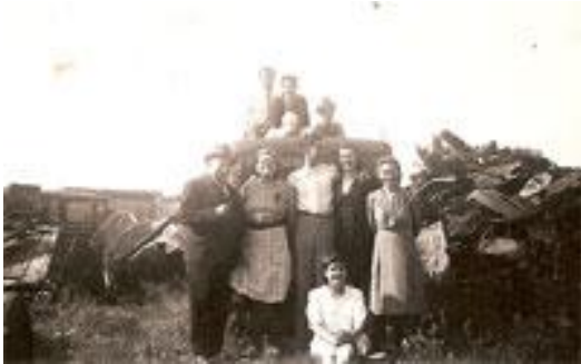
Figure 20 : La famille Fournier sur le chantier
