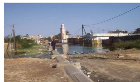
Photo 39 prise en 2009 La conduite d'eau ici au même niveau que la terre. Des roseaux encadrent la piste inondée. Zone un peu viabilisée avec les branchements d'électricité
