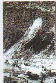
Photo N°7 Vue rapprochée de glissement induit 10/93
