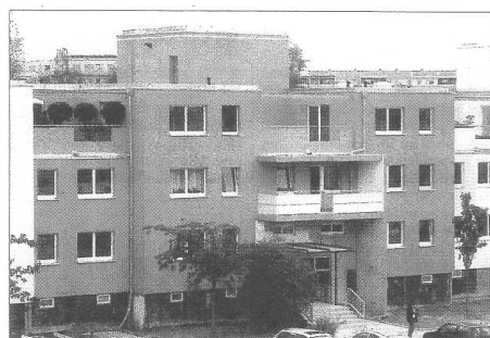
Die Ahrensfelder Terrassen: So sieht der Rückbau aus.
