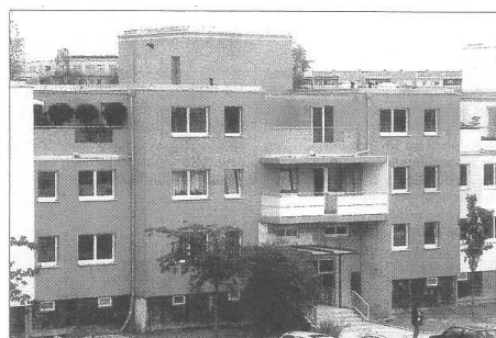
Die Ahrensfelder Terrassen: So sieht der Rückbau aus.
