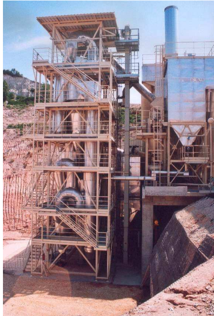
Figure III.4 : Photographie de la tour de calcination de Fumel
