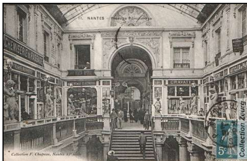
Photo 17 : Ancienne vue du Passage Pommeraye à la fin du XIXe siècle (Source http://zeurg.pagesperso-orange.fr/cartes_postales_anciennes_44.htm )
