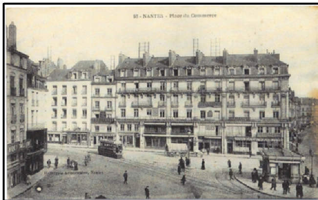
Photo 19 : La place du Commerce : terminus des transports en commun au XIX e siècle (Source : Archives Municipales de Nantes-9FI664)
