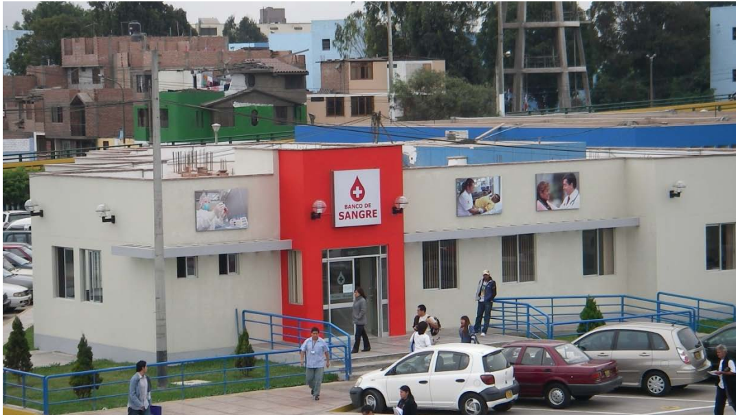
Photo n°40 : Banque de sang de l'hôpital Sabogal (EsSalud)
