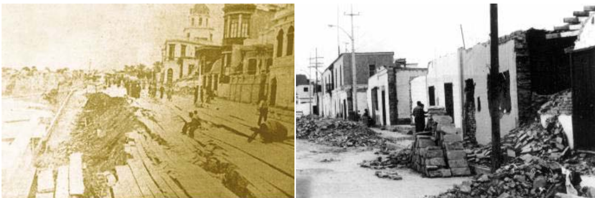
Photos n°14 et 15 : Dommages à Chorrillos suite aux séismes de 1940 (à gauche) et de 1974 (à droite)
