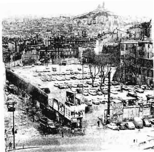
- 1960 : ci-contre les terrains en chantier derrière la Bourse
